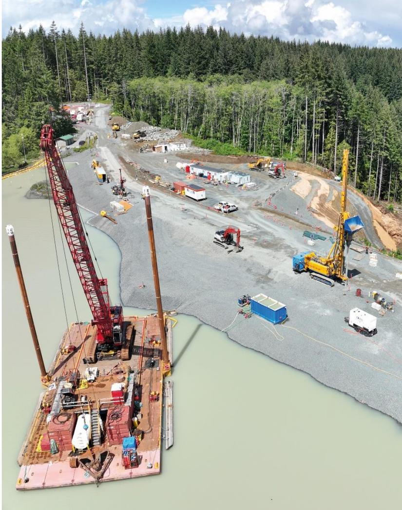
Kanada, John-Hart-Damm – Erdbetondichtwand
