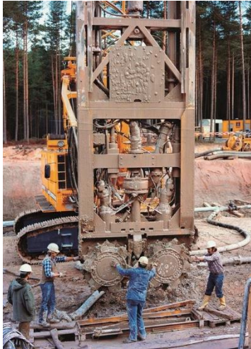
(1) Erste Bauer-Fräse bei der Abdichtung des Brombachspeichers im Jahr 1985.
