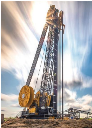
(2) Tiefenrekord: Im Jahr 2019 wurde mit einer Bauer-Fräse erstmals eine Tiefe von 251,4 m erreicht.
