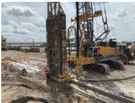
(2) Im Rahmen der Instandsetzung eines Deichs am östlichen Ufer des Mississippi setzt Bauer Foundation eine Kombination aus Greif- und Frästechnik ein, um eine einphasige Dichtwand herzustellen.
