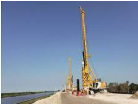
(1) Dichtwandarbeiten am Herbert Hoover Dike: Bauer konnte drei der fünf vergebenen Instandsetzungsabschnitte (Task Orders 1, 3 und 5) für sich gewinnen.
