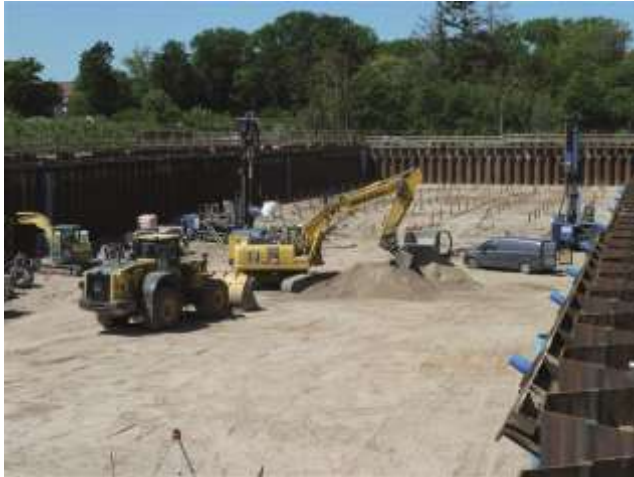
Bild: 2020-08_Bauer Umwelt builds geothermal plant:
