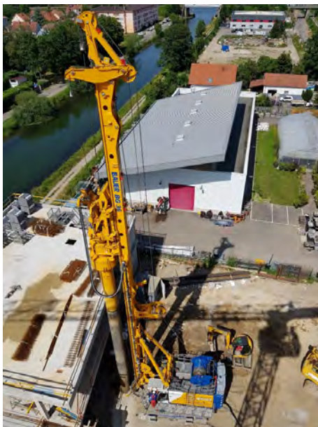
(1) BAUER BG 36 in Riedisheim, ausgestattet mit einem BTM 400 Bohrkopf für das Doppelkopfverfahren (DKS).
