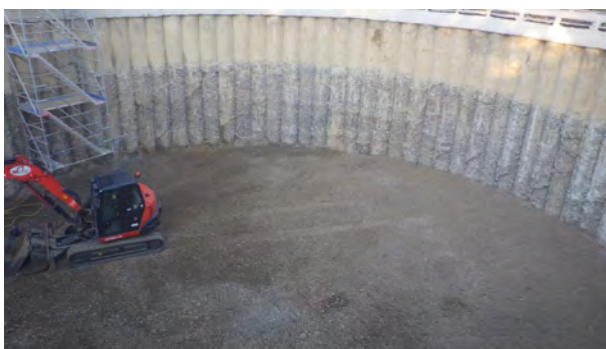
(2) Für ein Wasserrückhaltebecken stellte Durmeyer mit der BG 36 insgesamt 96 Pfähle mit einem Durchmesser von 880 mm.
