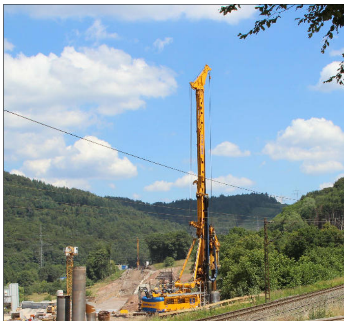
Das Projekt „Umfahrung Schwarzkopftunnel“ erstreckt sich in mehreren Abschnitten über etliche Kilometer.
