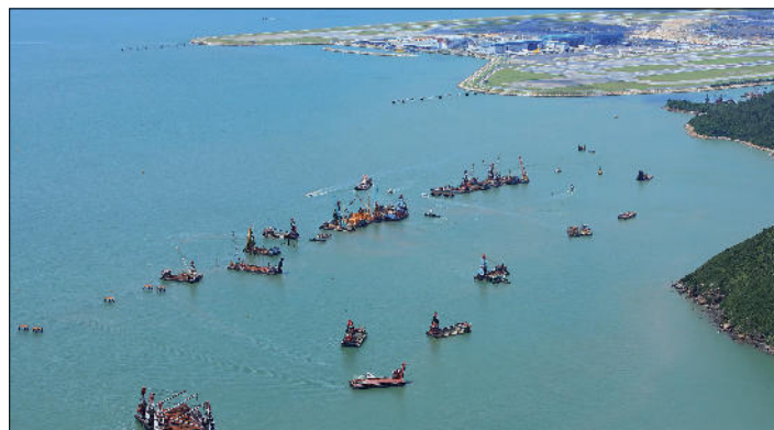
Aber noch sieht man auf dem Wasser nur Baustelle, im Hintergrund den Flughafen.
