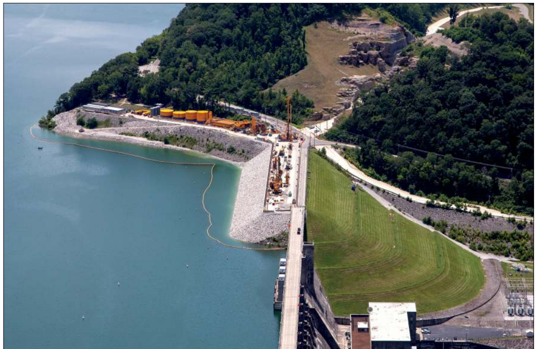
Am Center Hill Damm ist höchste Präzision gefordert. Mit eigens dafür modifizierten Geräten führt Bauer die Dammsanierung im US-Bundesstaat Tennessee aus.
