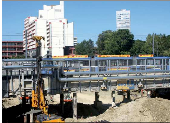
Der Straßenbahnverkehr verläuft weiterhin normal und quert über eine Trasse die Baustelle „Schwabinger Tor“.
