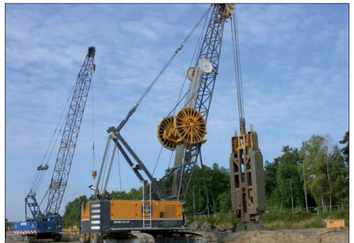
Der Schlitzwandgreifer bereitet die Aussteifung am künftigen Schleusenbecken vor.
