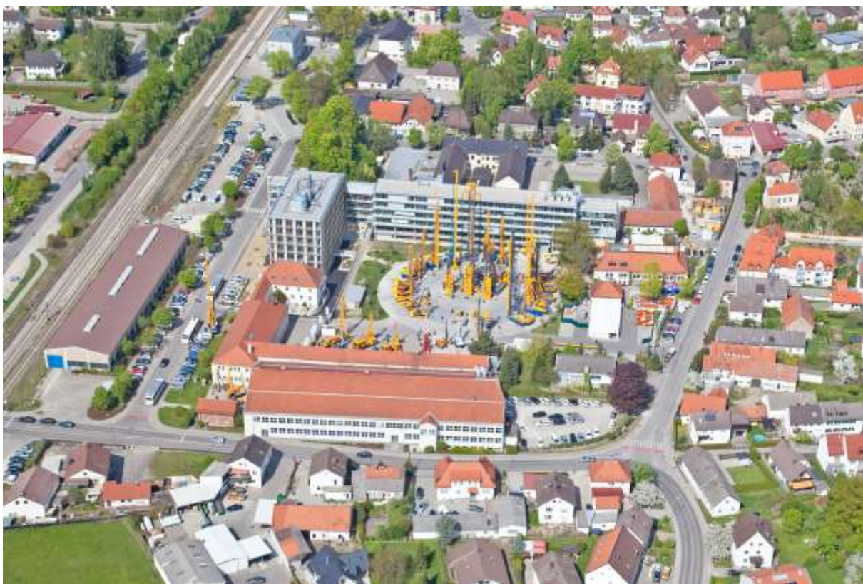
Abbildung 21: Luftbildaufnahme Verwaltung Schrobenhausen
