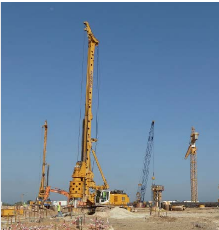
Gründungsarbeiten für das künftig höchste Gebäude der Welt, den Kingdom Tower in Saudi-Arabien.
