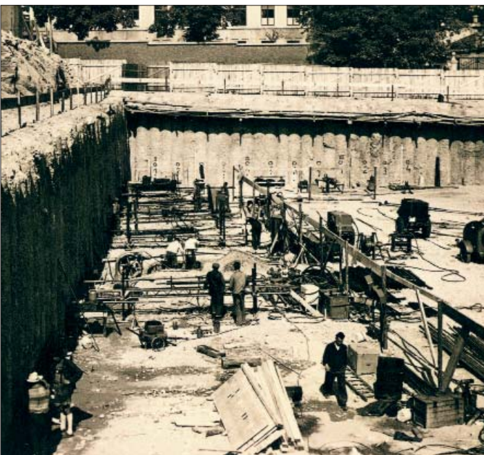
Erfindung des Injektionsankers auf der Baustelle des Bayerischen Rundfunks.
