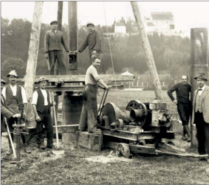
Brunnenbohren mit einem Dreibock bis in die 1950er Jahre.
