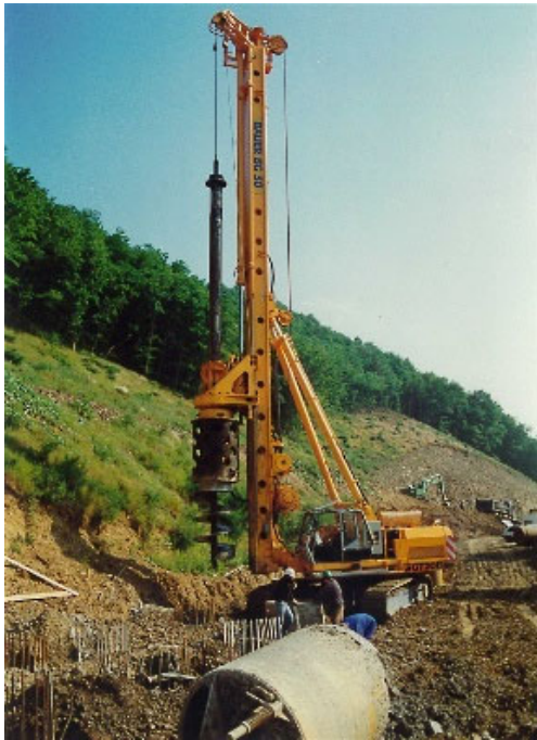
(2) Die BG 30 – hier bei Bohrpfahlarbeiten südwestlich von Bonn – feierte 1989 auf der bauma Premiere.
