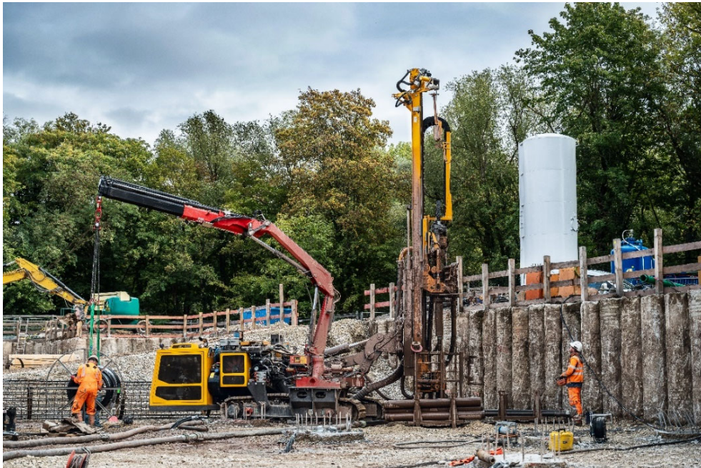
(2) Ein eingespieltes Team: Geothermie und Spezialtiefbau gehen hier Hand in Hand.
