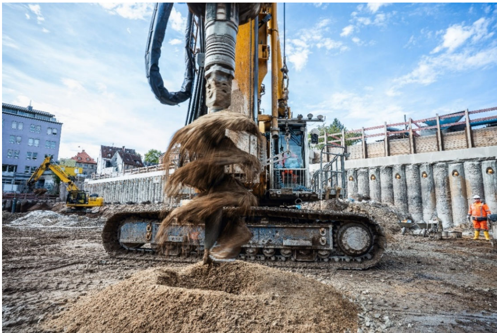
(3) Leistungsstark: Die BG 39 bei der Pfahlherstellung für das Fundament.
