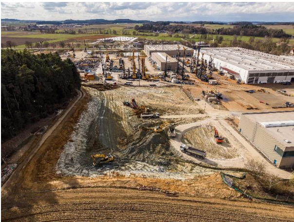
(2) Bauer Resources wurde mit den Erdarbeiten beauftragt.
