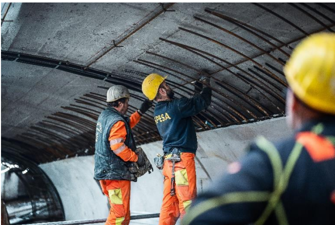
(3) 650 m 3 Ortbeton, 1.000 t Spritzbeton und 120 t Bewehrung kommen zum Einsatz.
