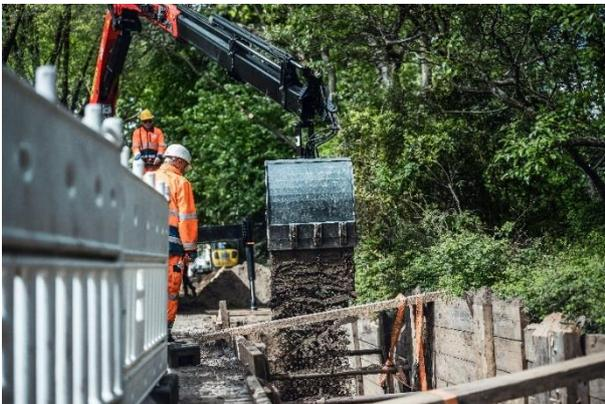
(3) Bei einem Leitungsbauprojekt am Jahning in Hamburg wird der aufbereitete Boden wieder eingebaut.
