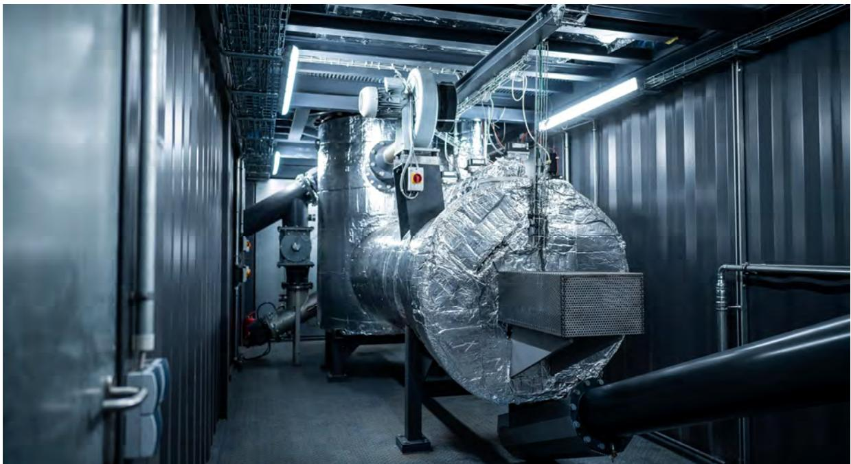
*Die Pyrolyseanlage von Carbo-FORCE karbonisiert Biomasse.*
