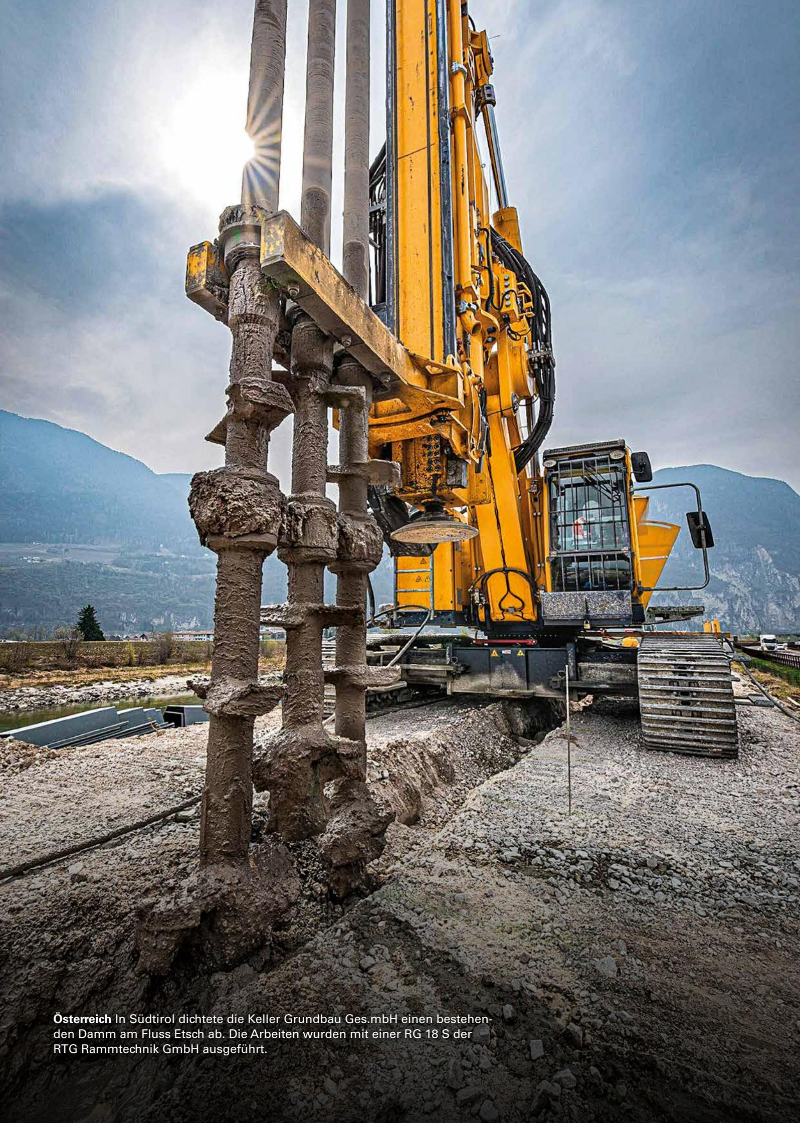
**Österreich** In Südtirol dichtete die Keller Grundbau Ges.mbH einen bestehenden Damm am Fluss Etsch ab. Die Arbeiten wurden mit einer RG 18 S der RTG Rammtechnik GmbH ausgeführt.
