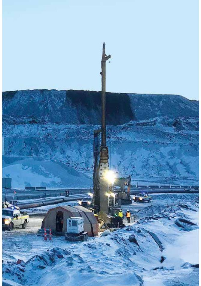
Rund 170 km nördlich des Polarkreises führte Bauer Feldversuche mittels Düsenstrahl- und Cutter-Soil-Mixing-Verfahren aus.
