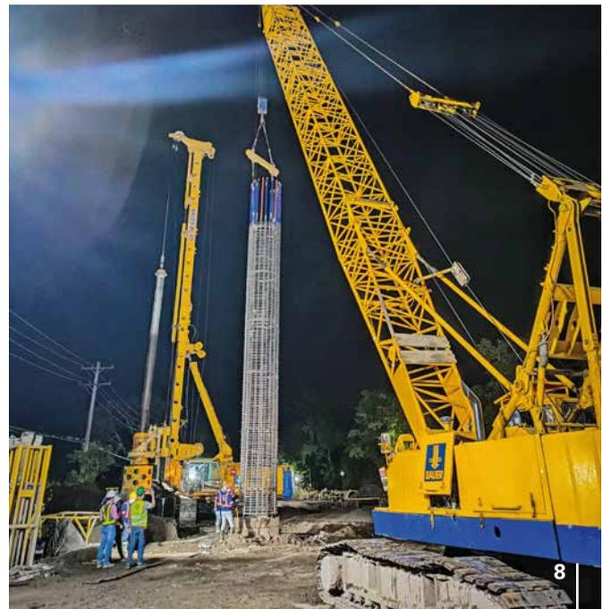
**8 | Philippinen** Für den Bau einer neuen Bahnstrecke in der Provinz Pampanga wurde Bauer mit den erforderlichen Bohrpfahlarbeiten beauftragt. Die Pfahldurchmesser variieren von 1.200 mm bis 1.800 mm.
