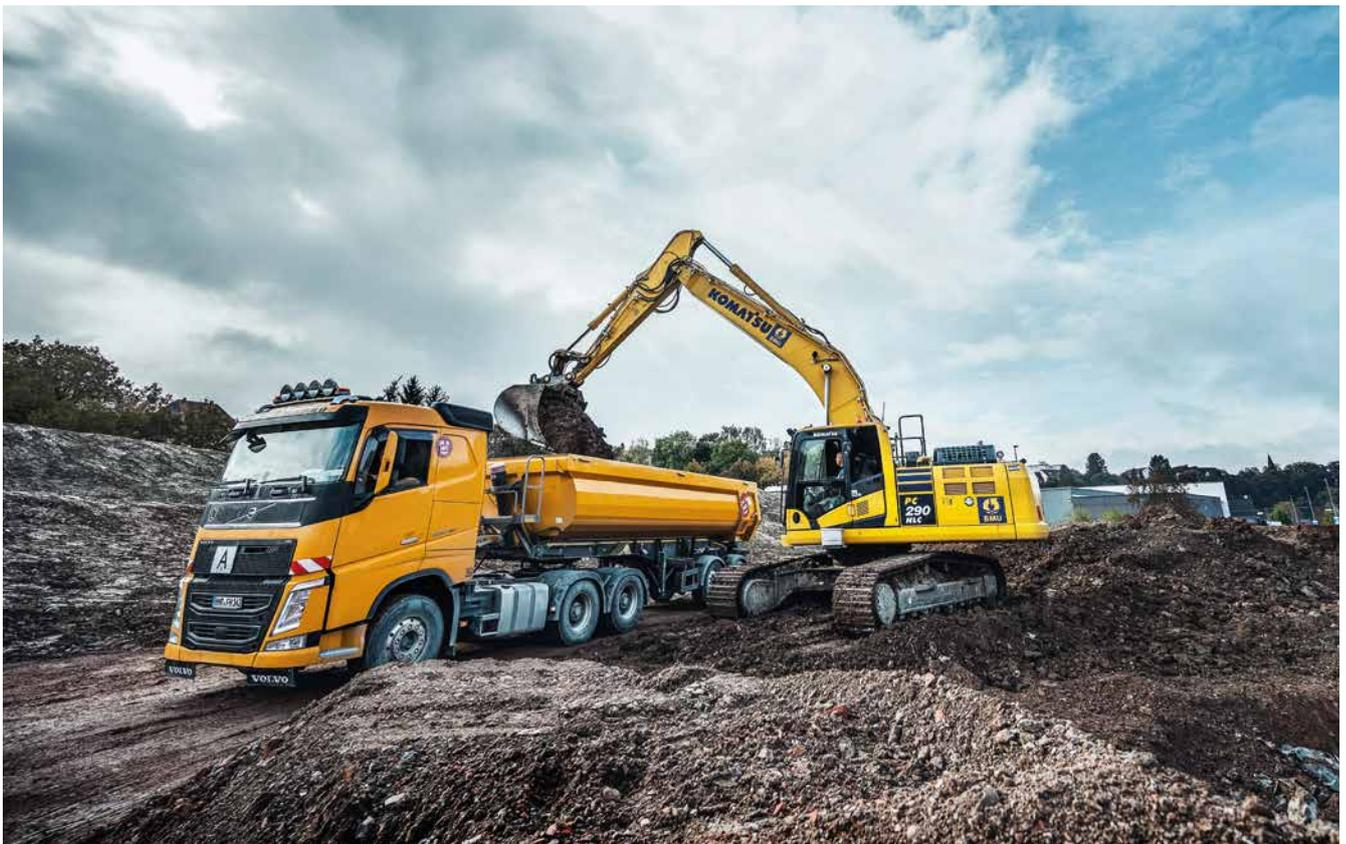
**Backnang** Unter extremen Witterungsverhältnissen wurde auf dem Areal einer ehemaligen Gerberei in Backnang vom Bereich Bauer Umwelt die Baugrube für ein Pflegeheim erstellt. Mit einem 30 t schweren Bagger wurden rund 26.000 m<sup>3</sup> belasteter Boden bis zu einer Tiefe von 4 m ausgehoben.
