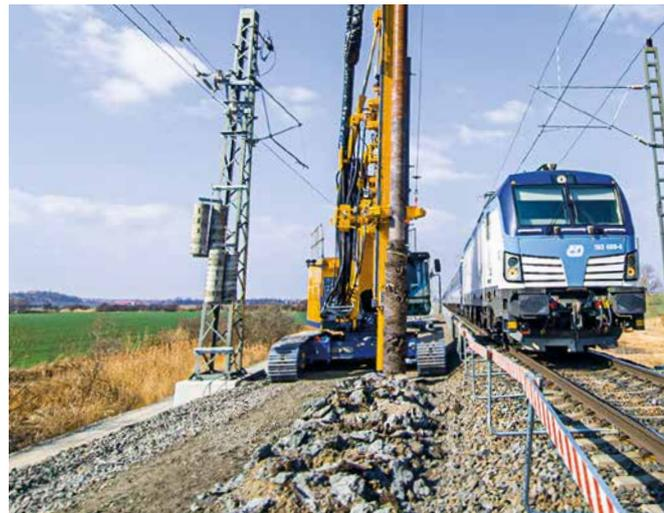
**8 | Polen** In Górká Węgieska wird eine Schnellstraße gebaut. Zur Befestigung der Böschung verwendet Keller Polska Sp. z o.o. ein KR 806-5G Bohrgerät der KLEMM Bohrtechnik GmbH.
