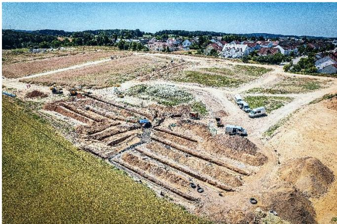
(1) Neubaugebiet „Kellerbergbreite“ in Schrobenhausen: Bauer Resources errichtete eine Erdwärmesondenanlage und ein kaltes Nahwärmenetz für insgesamt 64 Wohngebäude.
