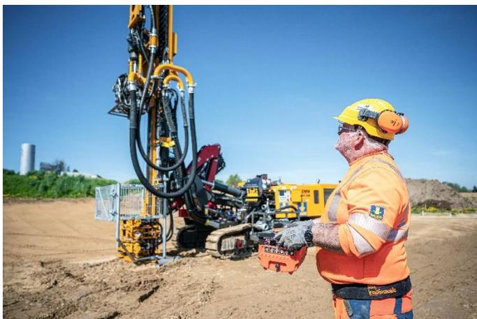
(2) Insgesamt wurden 119 Erdwärmesonden in bis zu 60 m Tiefe hergestellt.
