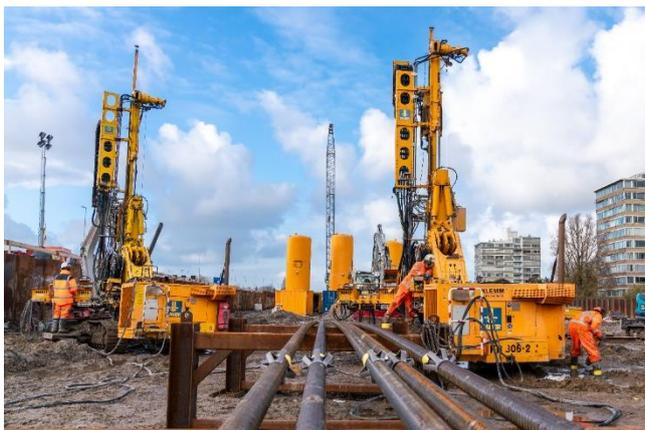
(2) Insgesamt werden auf einem 1,7 km langen Autobahn-Abschnitt ca. 12.000 Ankerpfähle bis in eine durchschnittliche Tiefe von 33 m gebohrt.
