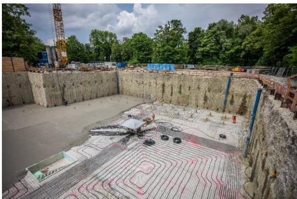
(2) Rund 3.000 m<sup>2</sup> Mixed-in-Place-Wand (MIP) und eine 2.500 m<sup>2</sup> große Bodenplatte wurden geothermisch aktiviert.
