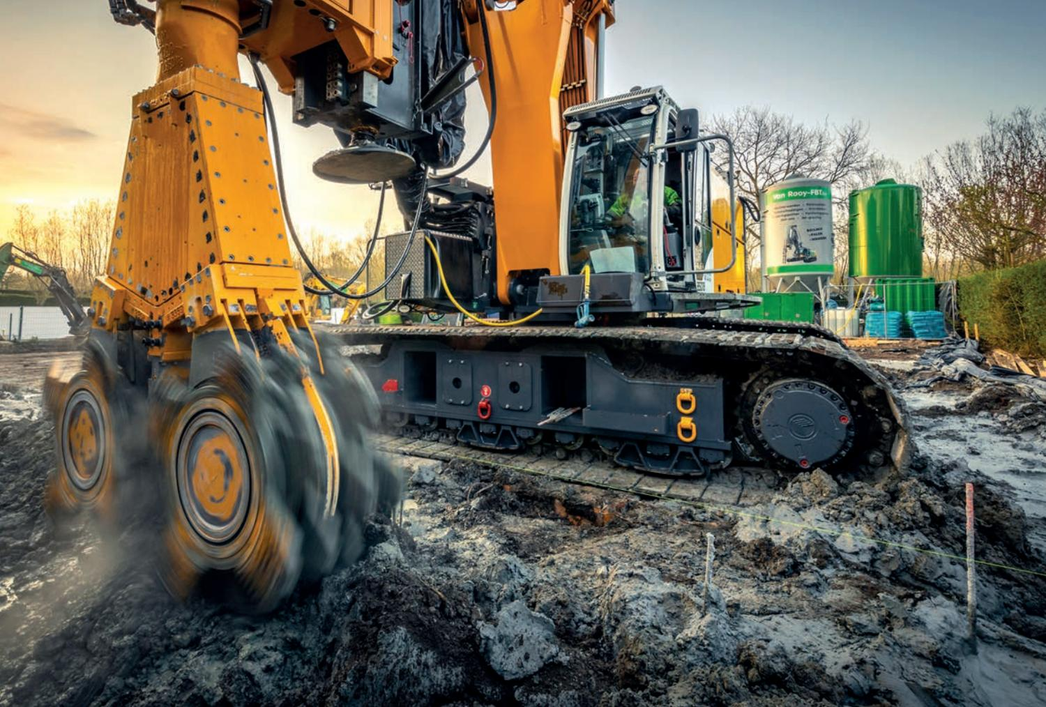
**Belgien** In Beerse setzte unser Kunde Van Rooy-FBT BVBA eine RG 27 S samt BCM-Mischeinheit zur Ausführung des Cutter-Soil-Mixing-Verfahrens (CSM) ein. **oben**
