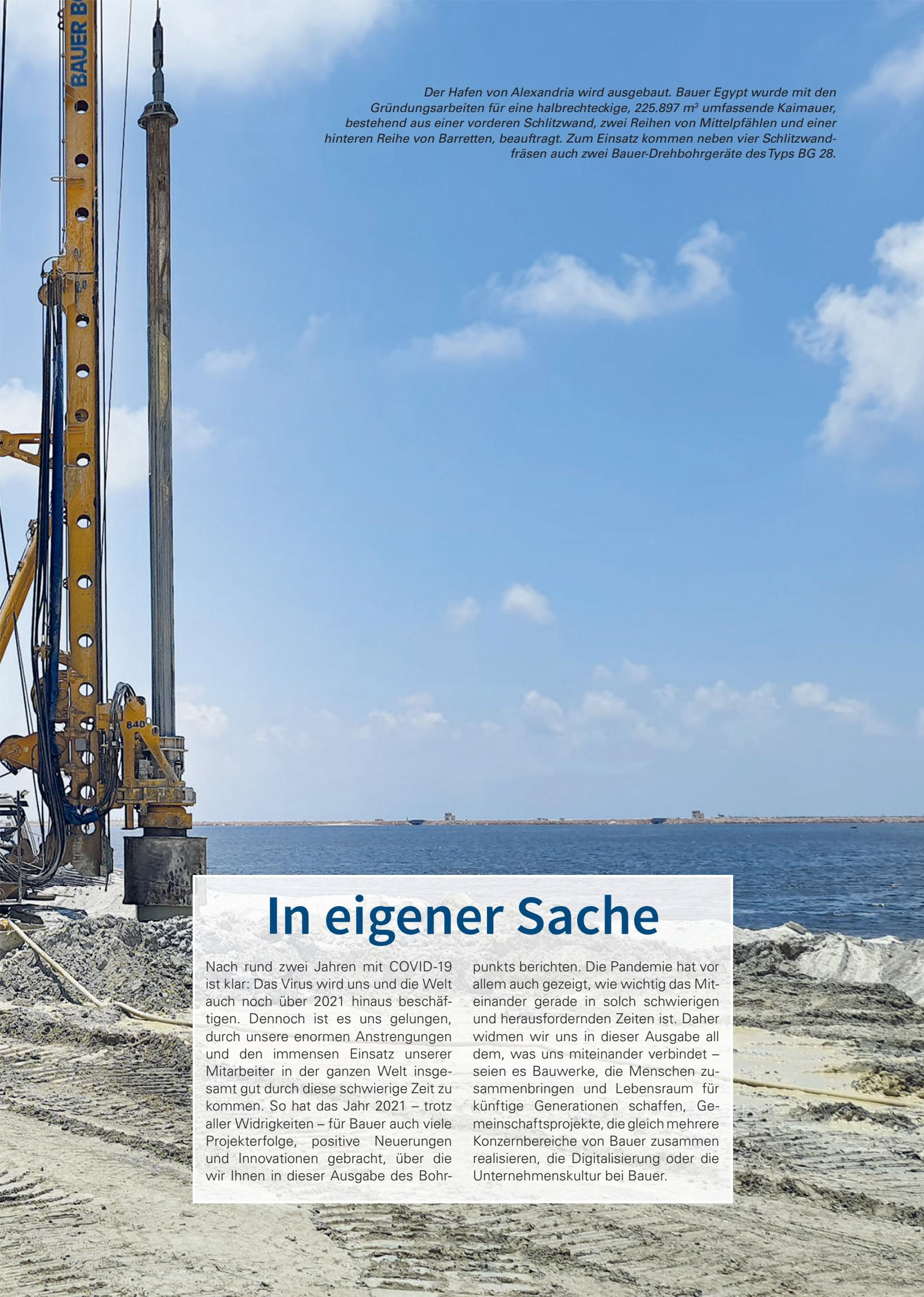
*Der Hafen von Alexandria wird ausgebaut. Bauer Egypt wurde mit den Gründungsarbeiten für eine halbrechteckige, 225.897 m<sup>3</sup> umfassende Kaimauer, bestehend aus einer vorderen Schlitzwand, zwei Reihen von Mittelpfählen und einer hinteren Reihe von Barretten, beauftragt. Zum Einsatz kommen neben vier Schlitzwandfräsen auch zwei Bauer-Drehbohrgeräte des Typs BG 28.*
