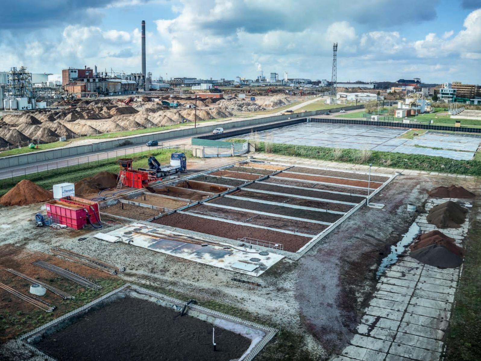
Auf dem Gelände der alten Raffinerie in **Leuna** hat der Bereich Bauer Umwelt eine Grundwasserreinigungsanlage errichtet, die seit 2014 täglich rund 500 m<sup>3</sup> belastetes Wasser auf rein biologische Weise mithilfe von Millionen Mikroorganismen reinigt. Aufgrund der nachhaltigen Betriebsweise können Stromersparungen von etwa 70 % sowie eine Reduktion der CO-Emissionen um rund 255.000 kg pro Jahr erzielt werden. **oben**
