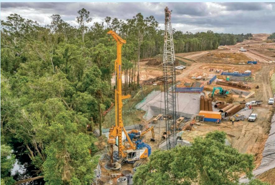
**Australien** Das Infrastrukturprojekt „Cooroy to Curra“ umfasst den Bau von 13 mehrspurigen Brücken auf einer Länge von 26 km. Mit einer BG 30 stellt das Bauer-Team bis zu 25 m tiefe, verrohrte Pfähle mit Durchmessern bis 1.800 mm inkl. Felseinbindung her. **links**
