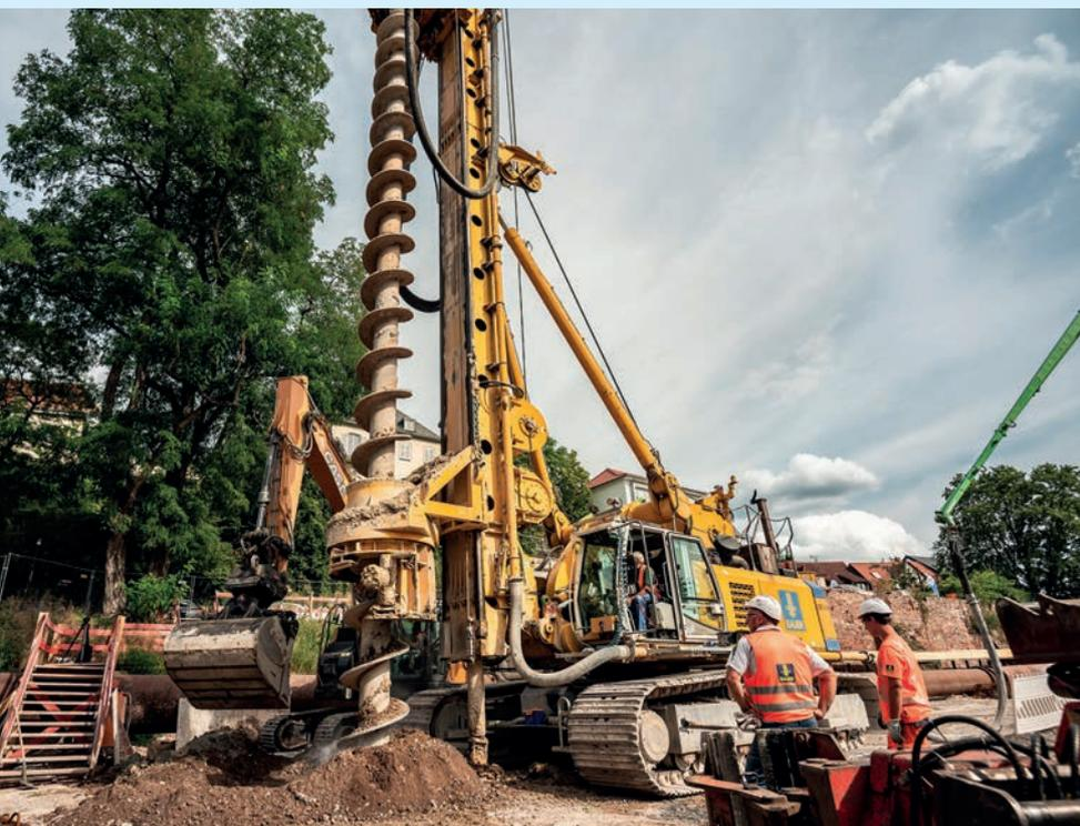
Für ein neues Abwasserbauwerk wurde in **Aschaffenburg** eine Baugrubenumschließung mittels überschnittener Pfahlwand im Schneckenortbetonverfahren bis in ca. 24 m Tiefe ausgeführt. Bauer brachte außerdem eine tiefliegende HDI-Sohle ein. **links**
