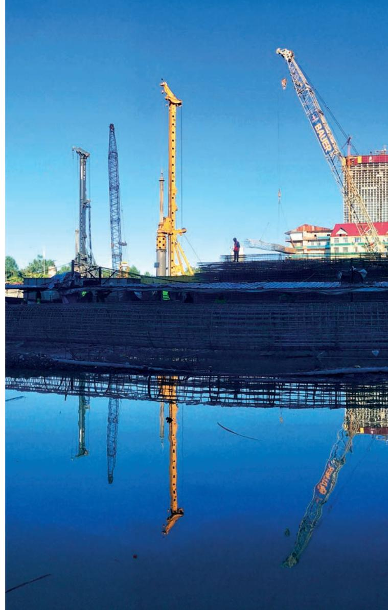
**Schweiz** Die 360 m lange Donnerbaumbrücke in Muttenz wird auf teilverrohrten Bauer-Pfählen mit Durchmessern zwischen 1.500 und 2.000 mm errichtet. Die beengten Platzverhältnisse und die Geländesprünge mit steilen Rampen erwiesen sich als Herausforderung. **oben**
