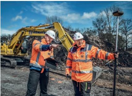
*Digitale Helfer: Bei einem Bodensanierungsprojekt des Bereichs Bauer Umwelt in Arnstadt kamen für die Vermessung des Geländes eine Drohne und ein Roverstab zum Einsatz.*
