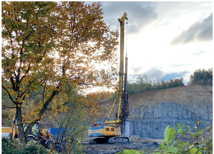
**Bulgarien** Die Section 1 des Hemus Highways erfordert ca. 3.500 lfm. Gründungspfähle bis in eine Tiefe von 25 m, inkl. Felseinbindung. Die teilverrohrten Pfähle bohrt Bauer mit einer BG 28 und einer BG 30. **oben**
