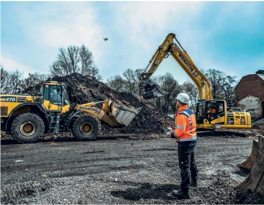
Was digitale Tools heute leisten können, zeigte der Bereich Bauer Umwelt bei einem Bodensanierungsprojekt in **Arnstadt**. Der Einsatz von Drohne, Roverstab und Tablet erleichterte die zentimetergenaue Vermessung des 12.000 m<sup>2</sup> großen Gaswerkgeländes. Nach den Vermessungsarbeiten erfolgten Austauschbohrungen mit einem Durchmesser von 1.800 mm bis in 7 m Tiefe. Dabei wurden insgesamt 9.100 m<sup>3</sup> Material ausgehoben und entsorgt. **links**
