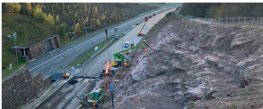
*Zur Vermeidung von Felsabstürzen und Rutschungen am Heidkopftunnel wurde die Spesa mit der Sicherung des 11.500 m<sup>2</sup> großen Felshangs beauftragt. Mithilfe von Teleskopbaggern und speziell ausgebildeten Höhenkletterern wurden insgesamt ca. 2.200 m Felsnägel und 5.400 m<sup>2</sup> Drahtgeflecht hergestellt.*
