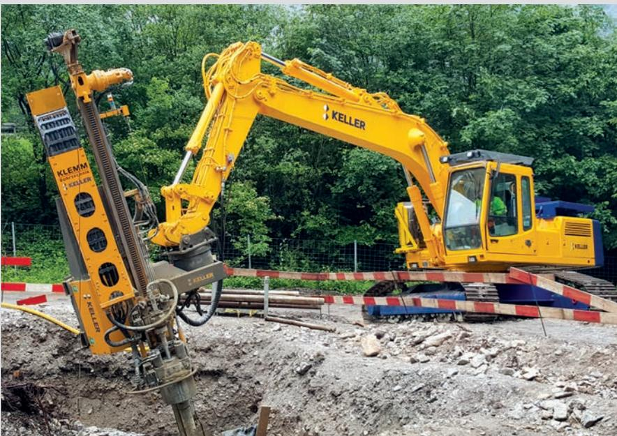
**Österreich** Die Keller Grundbau GmbH bohrte am Pass Lueg zur Gründung von Strommasten in unwegsamem Gelände Pfähle. Zum Einsatz kam ein KLEMM KA 163 Anbausystem mit einer kompakten DH 10 Doppelkopfbohranlage. **oben**
