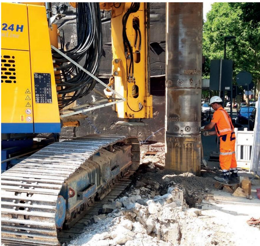
Beim Projekt 2. Stammstrecke **München** stellte das „Team Primärstützen“ der ARGE Tunnel Hauptbahnhof 2.500 m Stahlstützen mit einem Gewicht von 1.800 t ein. Insbesondere die schwierigen logistischen Randbedingungen und die hohen Anforderungen an die Vertikalität der Primärstützen stellten Herausforderungen dar. **oben**
