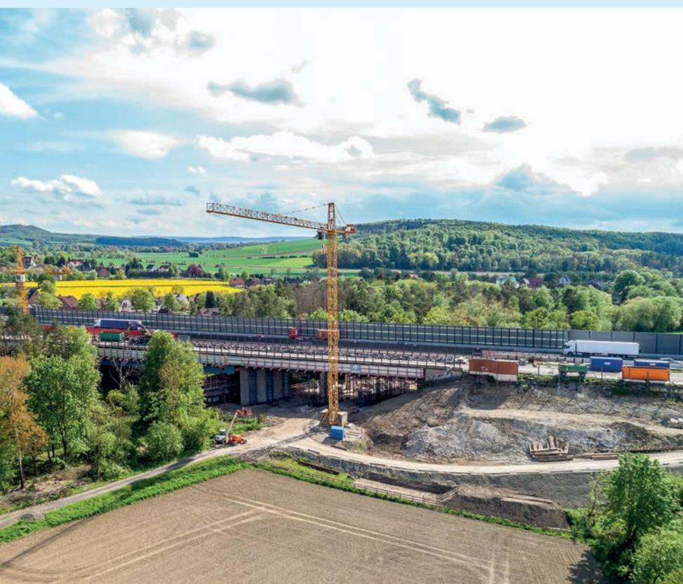
Im Rahmen des Ausbaus der A7 von nördlich Wöhlertalbrücke bis südlich des Autobahndreiecks **Salzgitter** wird die 150 m lange Innerstetalbrücke von der SPESA Spezialbau und Sanierung GmbH saniert. Die Arbeiten umfassen den Rückbau des Brückenbauwerks und den Ersatzneubau der Teilbauwerke einschließlich der Gründungsarbeiten. Die Entsorgung von kontaminierten Böden übernimmt der Bereich Bauer Umwelt. **links**
