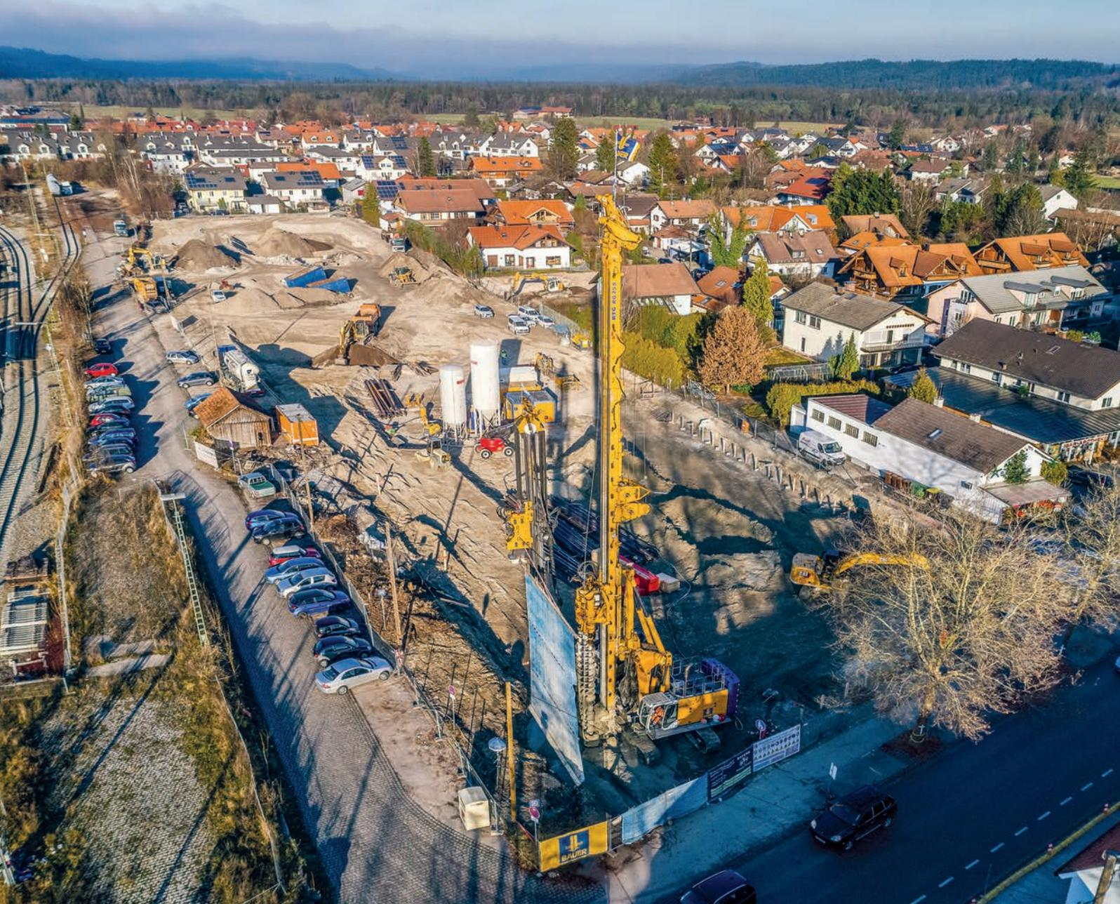
Für das neue Loisach Quartier im bayerischen **Wolfratshausen** erstellte Bauer eine Baugrube und errichtete insgesamt 5.500 m<sup>2</sup> statische Mixed-in-Place-Wand bis in eine Tiefe von 22,6 m.
