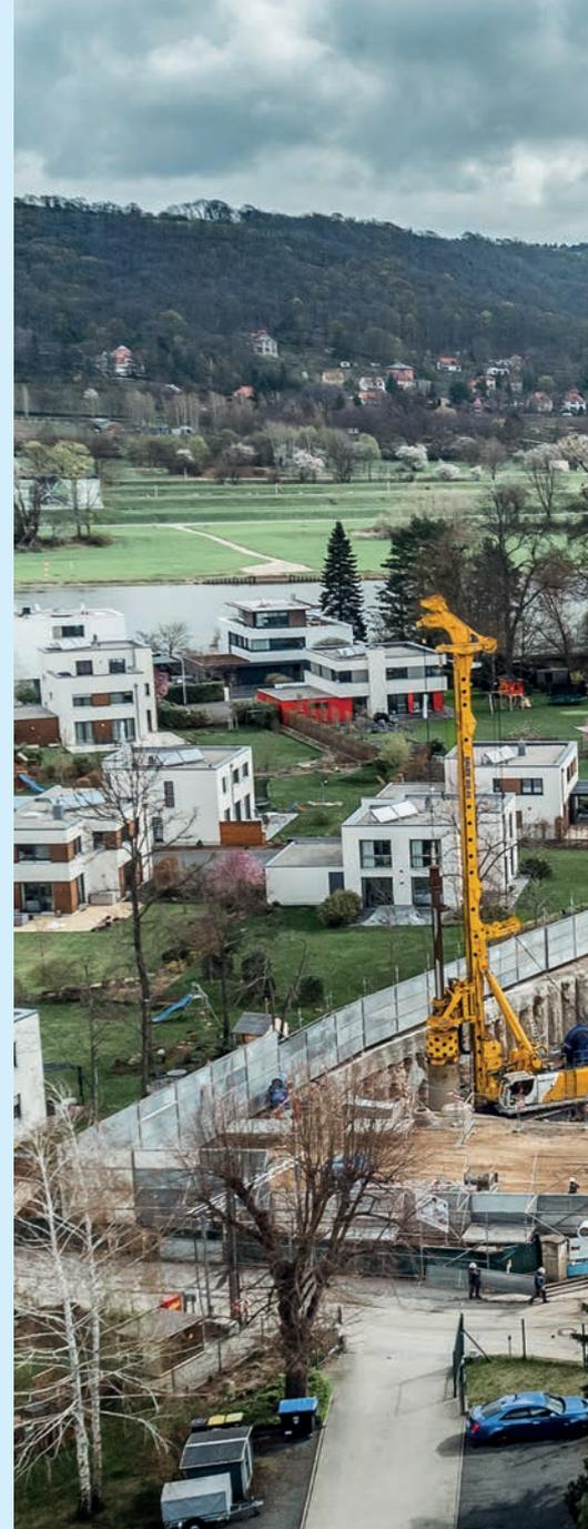
Wo gestern noch Kies abgebaut wurde, wird heute das Bauprojekt PANDION VERDE realisiert. Damit das neue Quartier auf dem ehemaligen Piederstorfer-Gelände in **München-Neuperlach** überhaupt entstehen kann, wurde der Bereich Bauer Umwelt mit der Baugru-benerstellung beauftragt. Mithilfe eines GPS-gesteuerten Baggers wurden über 25.000 m<sup>3</sup> belastetes Material ausgehoben und entsorgt. **oben**
