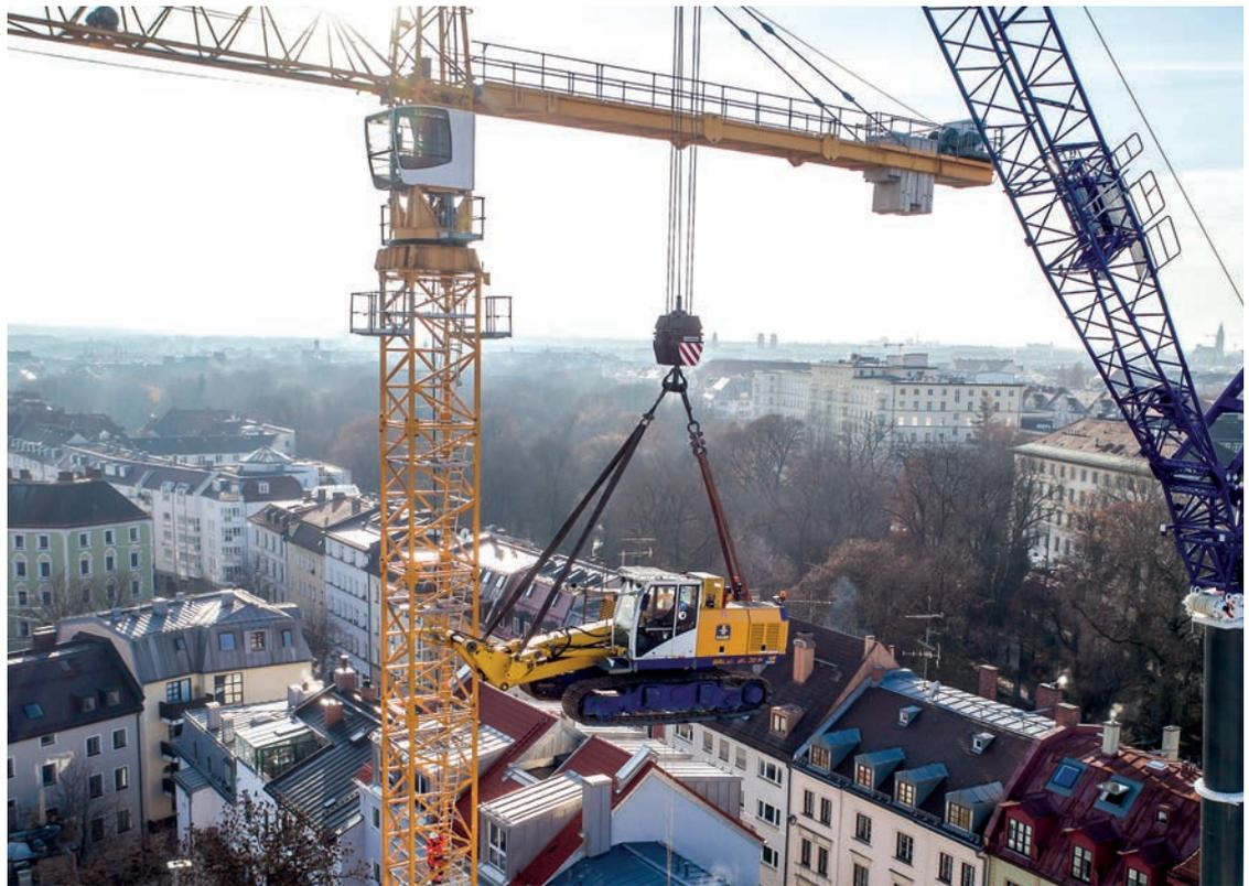
Baugrubenerstellung auf engstem Raum: Im **Münchner** Glockenbachviertel realisierte Bauer Spezialtiefbau eine Baugrube in einem Hinterhof. Das benötigte Material sowie eine BG 20 H mussten über die angrenzende Bebauung hinweg eingehoben werden. **oben**
