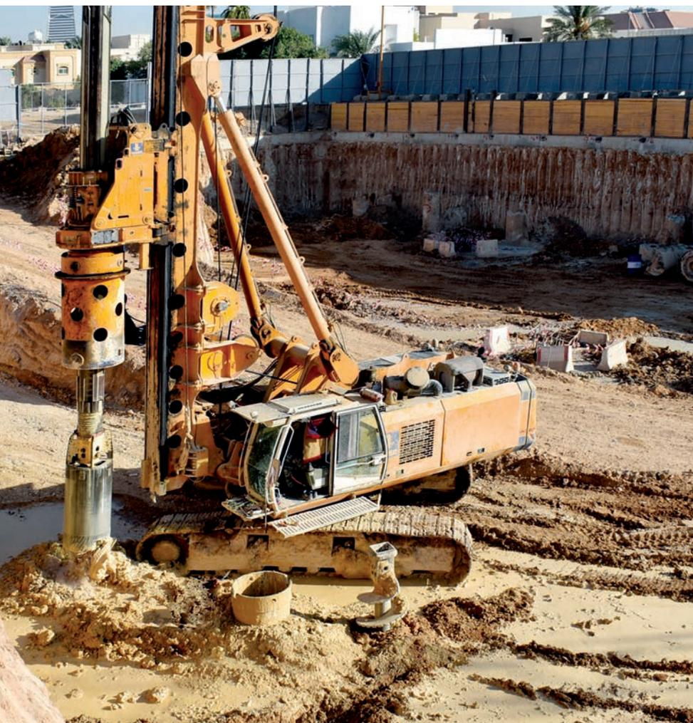
**Saudi-Arabien** In Riyadh entsteht auf einer Fläche von 160 ha ein botanischer Garten, für den Bauer bis zu 10 m lange Mikropfähle herstellte. Auch die Sondierung von Hohlräumen gehörte zum Leistungsumfang. **links**
