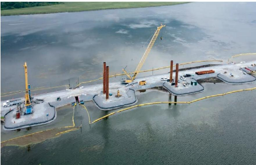
**Kanada** In Kingston wird eine 1,2 km lange Zweifeldbrücke über den Fluss Cataragui errichtet. Bauer stellte hierfür mit einer BG 39 und einem Vibrationshammer insgesamt 46 in den Fels eingebundene Schächte bis in 55 m Tiefe her. **oben**
