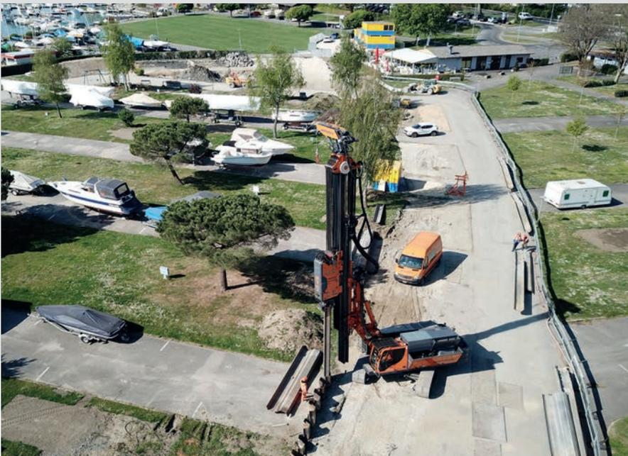
**Irland** In Dublin stellte unser Kunde Brazil Piling and Foundations mit einer BG 23 H eine überschnittene Bohrpfahlwand mit 880 mm Durchmesser her. **unten**
