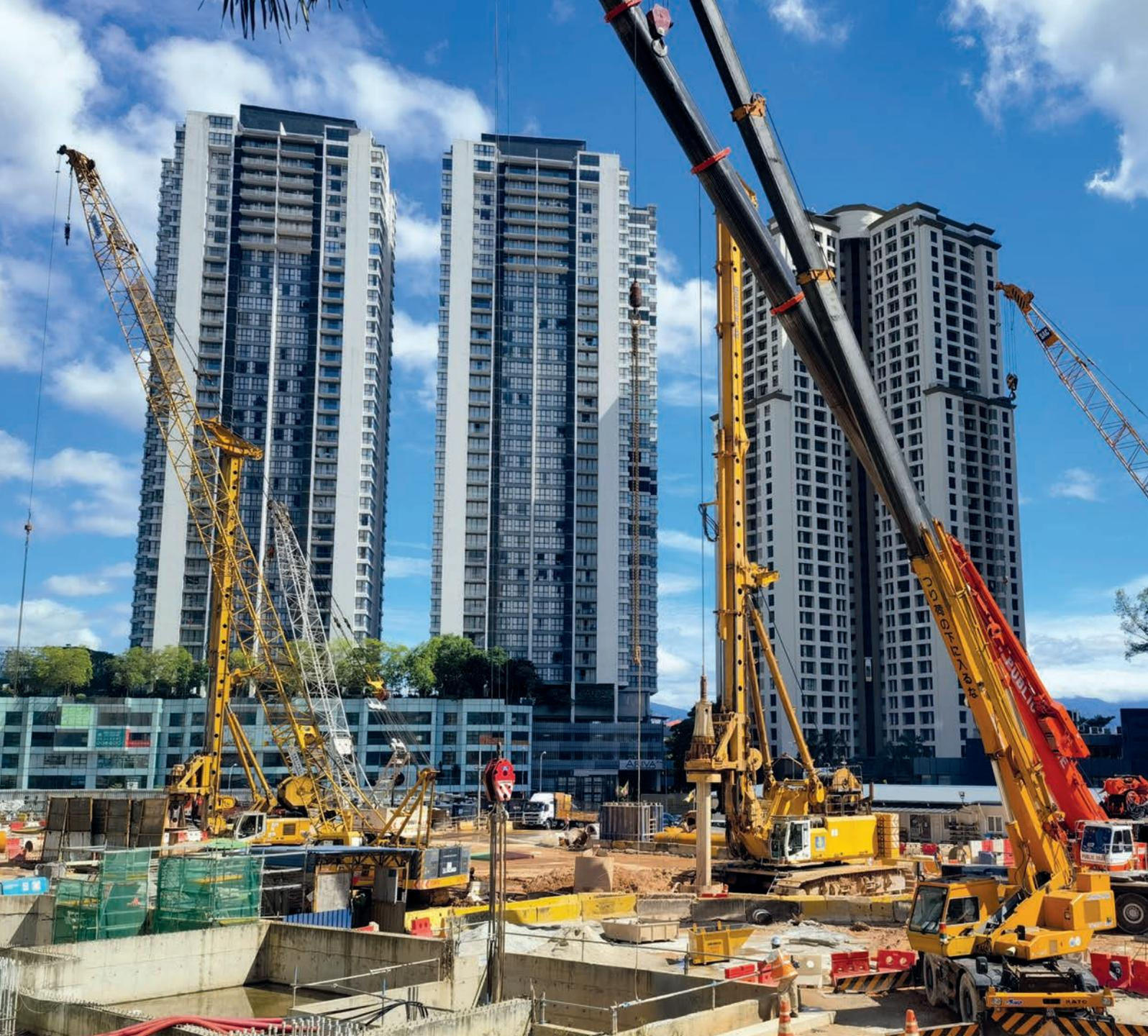
**Malaysia** Nach der Entfernung bereits bestehender Pfähle führte Bauer im Ampang Park von Kuala Lumpur Bodenaustauschmaßnahmen sowie Pfahlbohrarbeiten für einen Neubau aus. Vier BAUER BGs kamen zum Einsatz. **oben**
