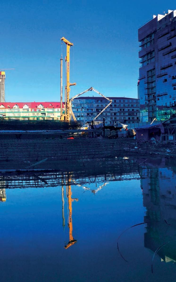
**Vereinigtes Königreich** Als Teil der Erschließung einer neuen Polyhalit-Mine in North Yorkshire stellte Bauer mit einem BG 39 Bohrergerät einen Tunnelzugangsschacht aus 29 überschnittenen Pfählen bis in 30 m Tiefe her. **unten**
