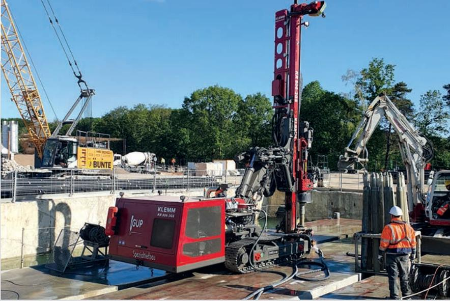
**Deutschland** Die GUP GmbH führte mit einer KLEMM KR 806-3GS Mikropfahlbohrungen zur Auftriebssicherung im Rahmen des Neubaus der Großen Schleuse Gleesen durch. **oben**
