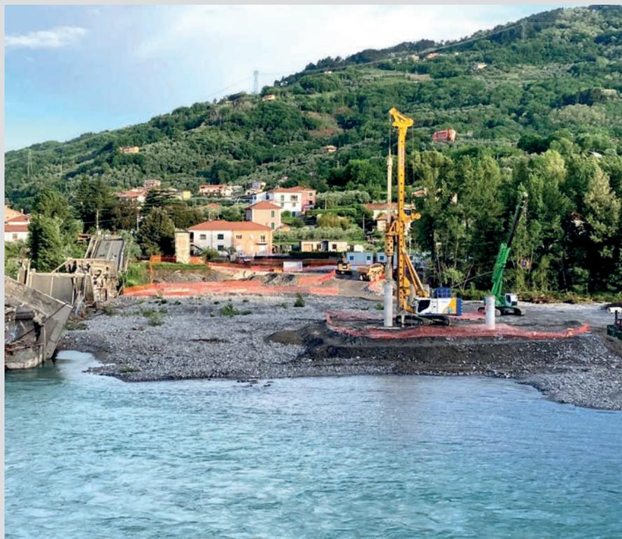
**Italien** Für eine neue Brücke über den Fluss Magra stellte unser Kunde C.G.X. Costruzioni Genareali Xodo S.R.L. mit einer BG 33 überschnittene Pfähle mit einem Durchmesser von 880 mm her. **oben**
