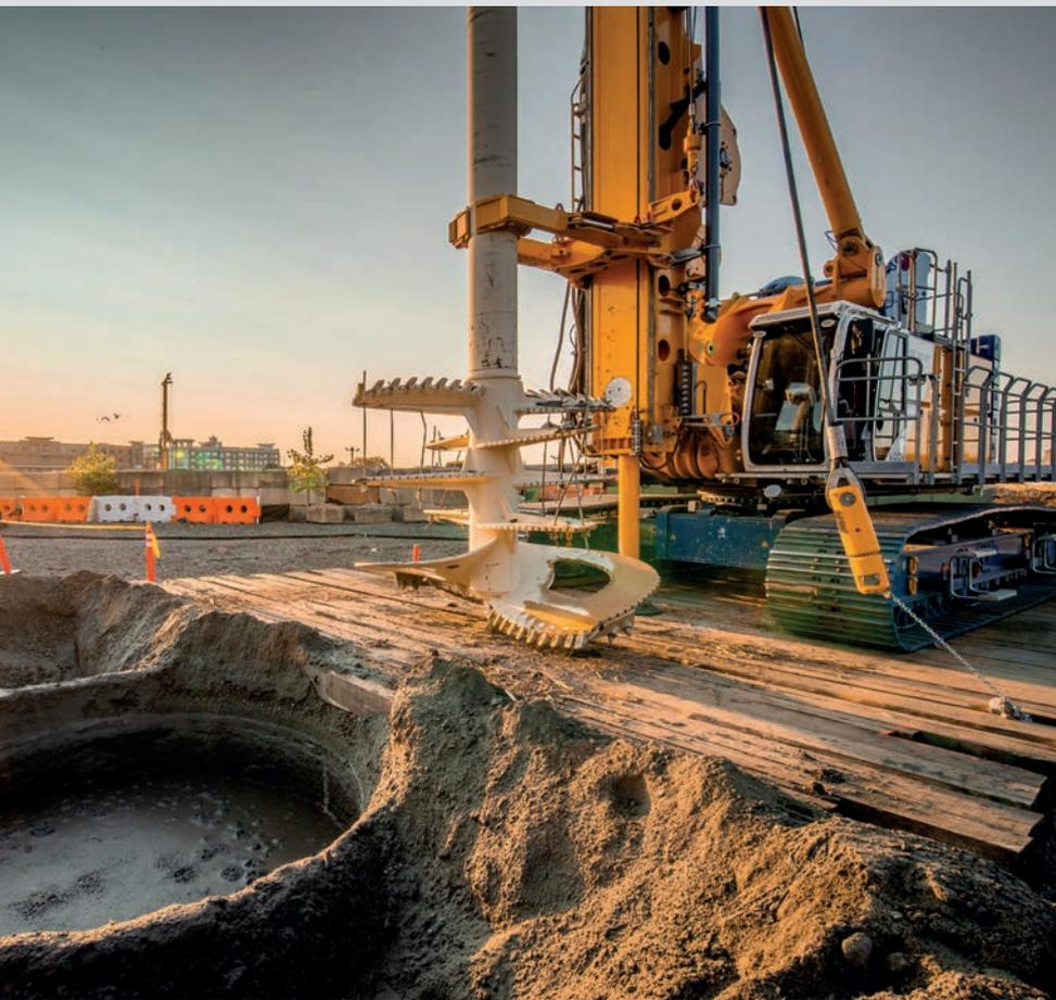
**USA** Mit zwei BG 45 Bohrgeräten samt SCM-Ausrüstung sowie mehreren Bauer MAT-Anlagen führte Severson Environmental Services, Inc. in Harrison, New Jersey, Baugrundverbesserungsmaßnahmen durch. **oben**
