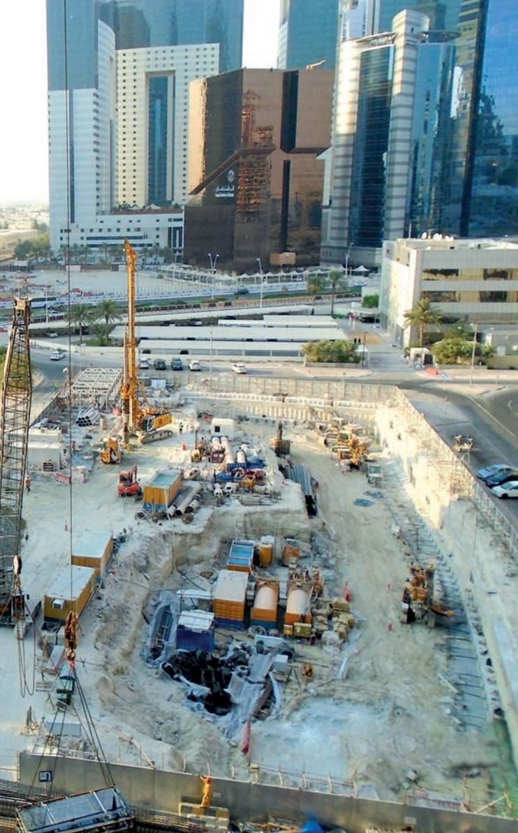
**Katar** Im Rahmen eines Stadtentwicklungsprojekts in Doha stellt Bauer nahe der Corniche Road mittels mehrerer BGs 408 überschneitene Pfähle sowie 104 Bohrpfähle her. Des Weiteren werden 774 Anker eingebracht. **unten**
