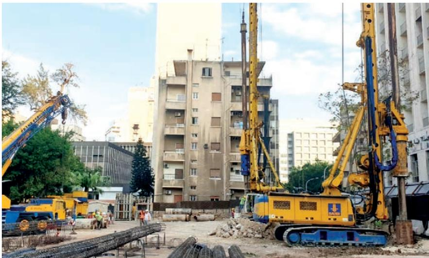
**Libanon** Für das neue medizinische Zentrum der American University of Beirut führte Bauer die Spezialtiefbauarbeiten aus, die u. a. den Erdaushub bis in 43 m Tiefe umfassten. Zur Ausführung der Pfahl- und Ankerarbeiten kamen eine BG 15, eine BG 28 sowie ein KLEMM-Gerät zum Einsatz. **oben**
