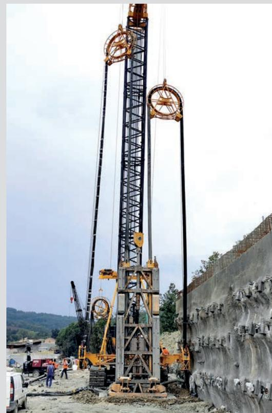
**Italien** Zwischen Gamberale und Civitaluparella wird eine neue Autobahn gebaut. Zur Herstellung einer bis zu 36 m tiefen und 1,2 m mächtigen Dichtwand setzte De Sanctis Costruzioni u. a. einen MC 96 Seilbagger mit BC 40 Fräse und eine MAT BE 500 Anlage ein. **oben**
