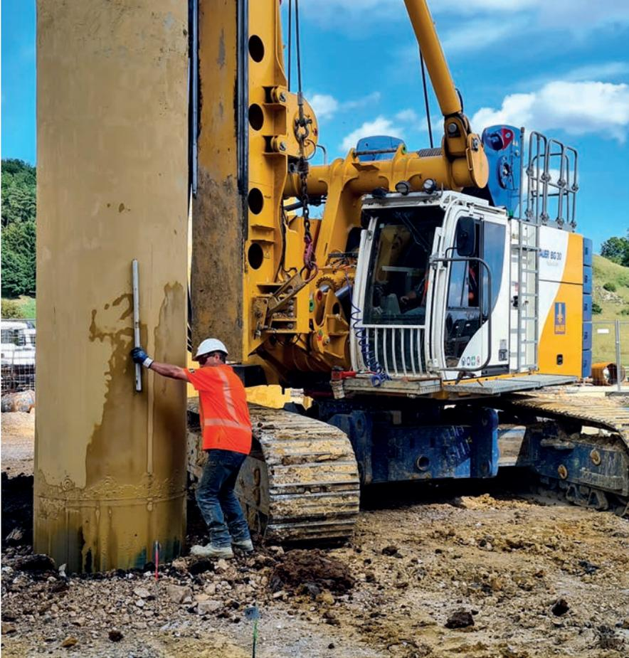
Mithilfe einer BG 30 wurden auf dem Areal eines Zementwerks im schwäbischen **Harburg** für eine Ofenanlage 130 Gründungspfähle mit einer max. Länge von ca. 24 m sowie mit Durchmessern zwischen 620 mm und 1.180 mm gebohrt. **links**
