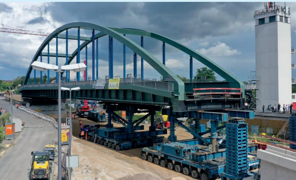
Verschub eines Schwergewichts aus Stahl: Am 22. August wurde die Eisenbahnüberführung **Rüdesheim** in die Endlage verschoben. Die gut 1.000 t schwere Stabbogenbrücke ist eines von derzeit sieben Stahlbauprojekten, die die SCHACHTBAU NORDHAUSEN Stahlbau GmbH für die Deutsche Bahn AG realisiert. **oben**
