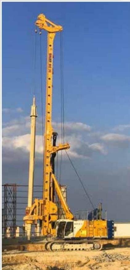
**Ägypten** Der Kunde Arab Contractors Mechanical & Electrical Engineering führte mit einer BG 36 V im Kellybohrverfahren Gründungspfähle bis in 30 m Tiefe aus. **oben**
