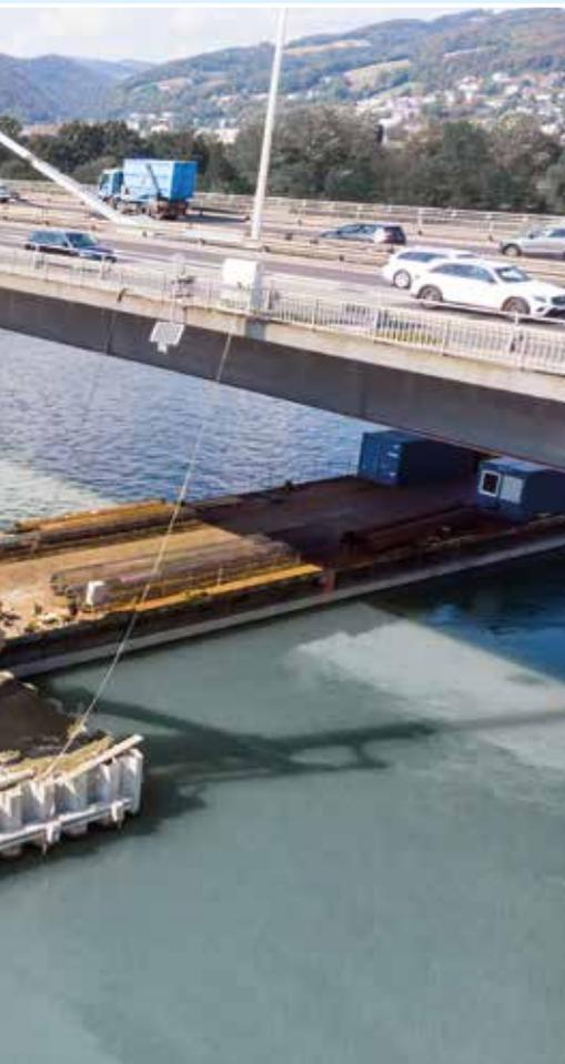
**Österreich** Für die Sanierung und Verkehrsertüchtigung einer Autobahnbrücke über die Donau in Linz wurden etwa 10.000 m Bohrpfähle hergestellt. Zusätzlich brachte Bauer für die Tiefengründung von insgesamt vier Pfeilerstandorten für zwei Bypass-Brücken rund 1.600 m Bohrpfähle ein, die über zuvor gefertigte Spundwandkästen in der Donau hergestellt wurden. **links**
