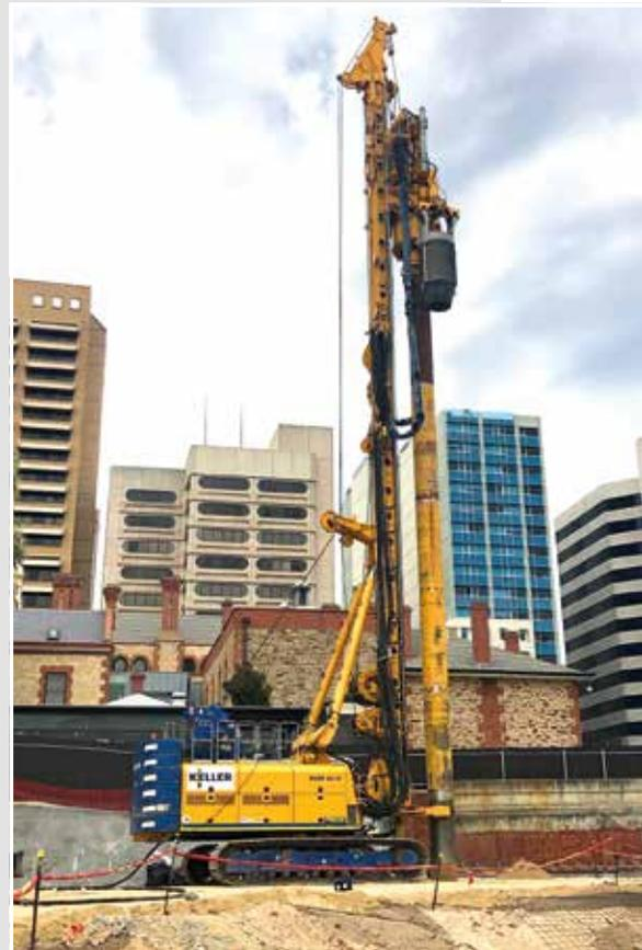
**Australien** In Adelaide verwendete Keller Australien für den Bau eines fünfstöckigen Parkhauses eine BG 30 mit verrohrter Endlosschnecke. **oben**
