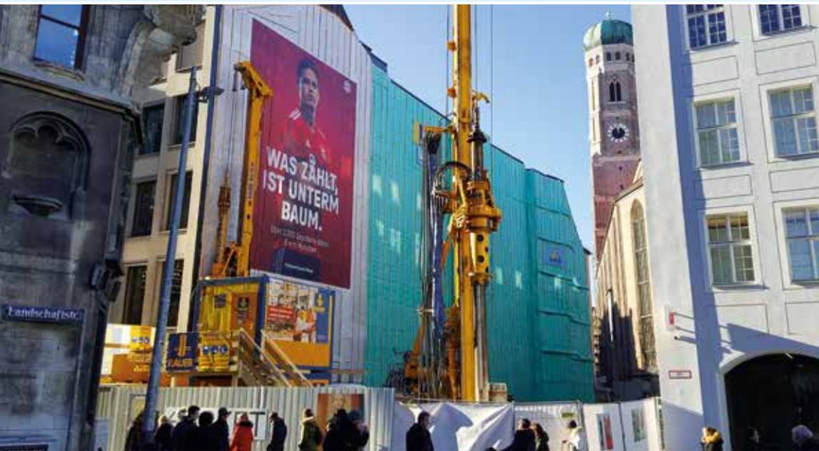
Mithilfe einer BG 30 und einer BG 15 H wurde im Zentrum von **München** zwischen Rathaus und Frauenkirche ein Baugrubenverbau im Vorder-Wand-Verfahren bis in eine Tiefe von 18 m ausgeführt. **oben**
