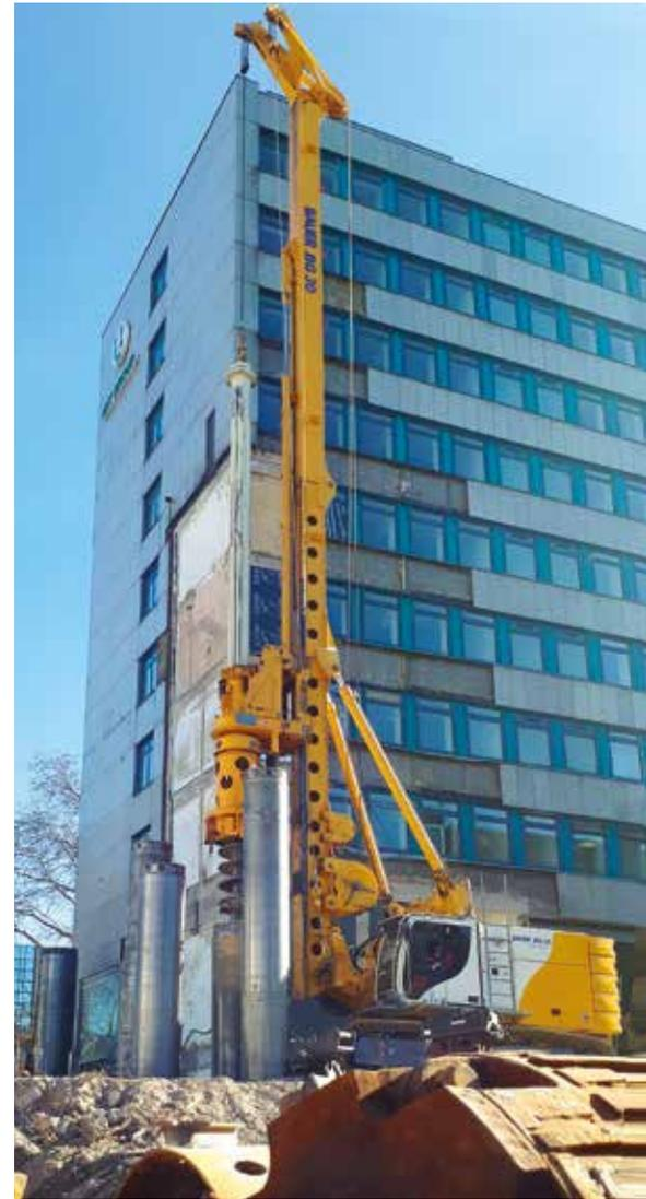
Neben der Dekontamination und dem Abbruch der vorhandenen Bestandsbebauung wurden für das Huyssen Quartier in **Essen** 1.550 m<sup>2</sup> Bohrpfahlwände und 1.680 m<sup>2</sup> aufgelöste Pfahlwände mit Spritzbetonausfächung erstellt. Eine besondere Herausforderung stellten die engen Platzverhältnisse im Innenstadtbereich dar. **oben**
