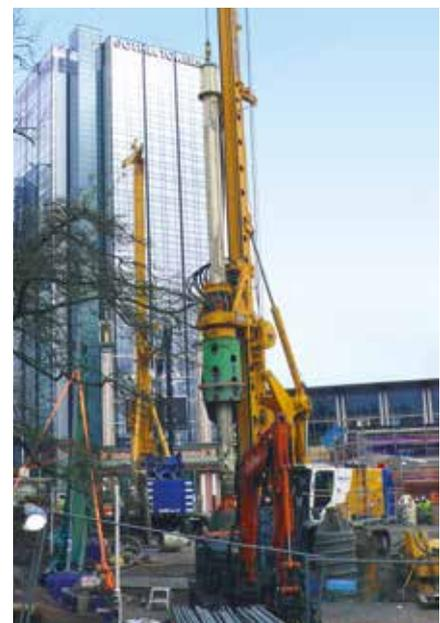
**Schweden** Zur Absicherung eines Tunnelportals für die neue U-Bahn in Göteborg stellte Bauer links und rechts neben der U-Bahntrasse eine Pfahlwand aus rund 60 Pfählen in bis zu 35 m Tiefe her. **oben**
