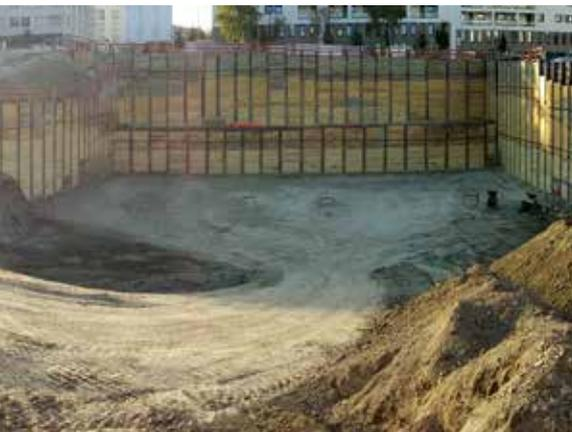
In **Stuttgart** entsteht ein Neubauprojekt, das urbanes Wohnen in einer grünen Umgebung ermöglicht. Insgesamt stellte Bauer 3.300 m<sup>2</sup> Berliner Verbau mit 127 Verbasträgern bis in eine Tiefe von 18 m her. **oben**
