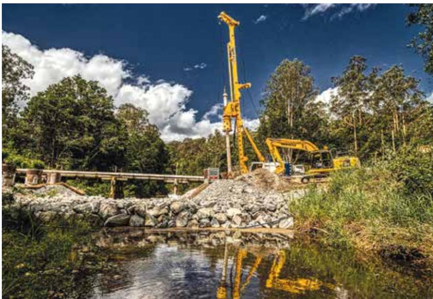
**Australien** Zur Herstellung von Fundamenten für fünf Brücken in Queensland konnten bereits zwei Wochen nach Auftragsvergabe zwei BG 30 Bohrgeräte mobilisiert werden, um die Fundamente mittels Bohrpfählen herzustellen. Für jede Brücke wurden zwei Widerlager mit vier Pfählen bis 3,5 m in den Felsuntergrund eingebracht. **oben**
