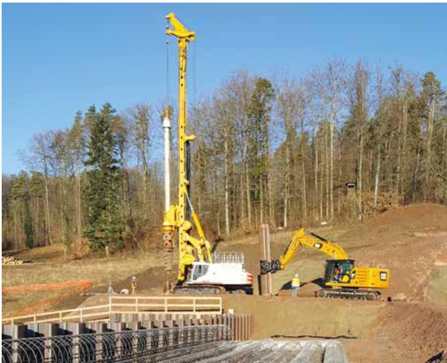
In **Schwörstadt** stellte Bauer für den Bau einer Deodorierungsanlage eines Ferngasleitungsnetzbetreibers rund 3.500 m<sup>2</sup> rückverankerte Spundwand zur Geländeprofilierung sowie 700 lfm Bohrpfahlgründung her. Die Arbeiten fanden aufgrund der Nähe zu teilweise in Betrieb befindlichen Hochdruckgasleitungen unter strengen Sicherheitsvorkehrungen statt. **oben**
