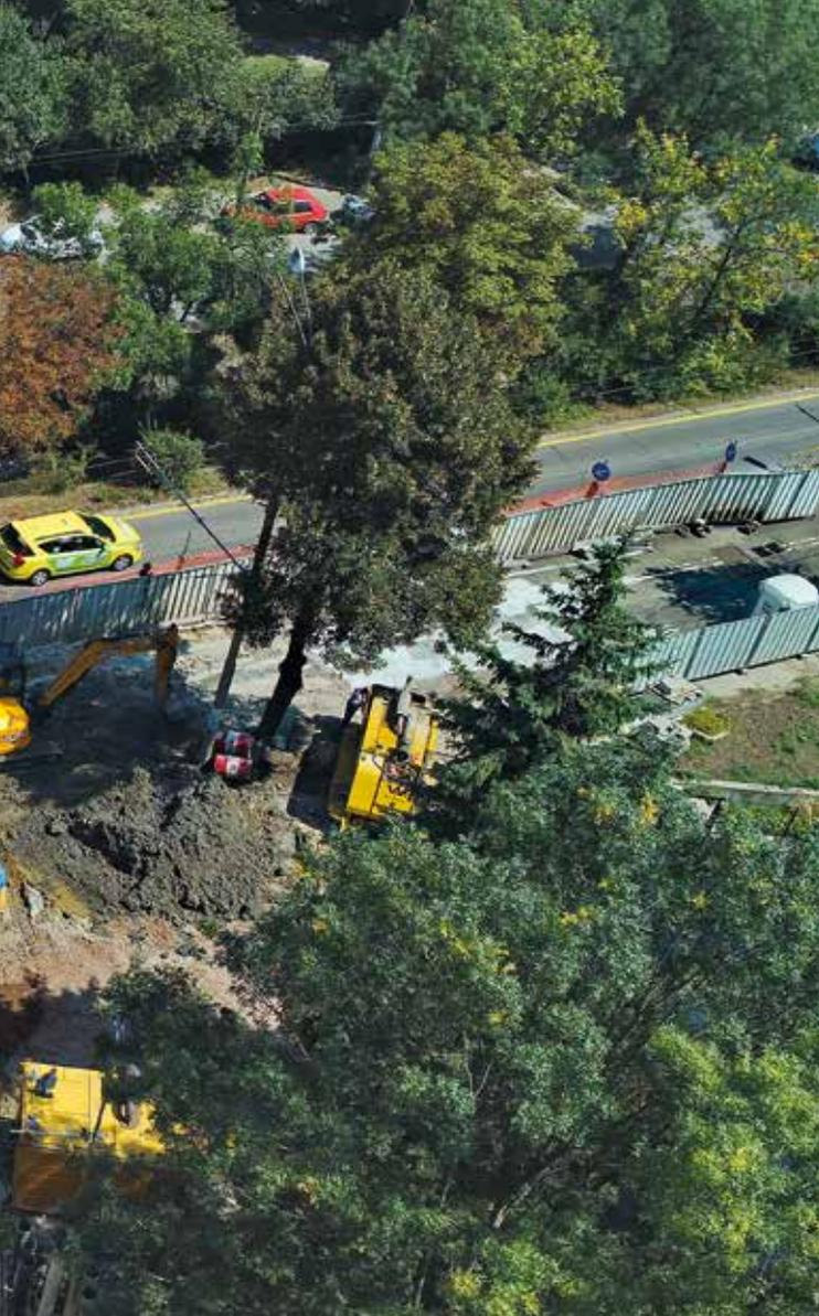
**Ungarn** Für ein neues Sportzentrum im Herzen von Budapest wurden auf engstem Raum rund 2.000 m<sup>2</sup> Schlitzwand bis in eine Tiefe von 20 m hergestellt. Die Erdarbeiten umfassten den Aushub von rund 11.000 m<sup>3</sup> Erdreich bis in eine Tiefe von 18 m unterhalb der Geländeoberkante – eine für Ungarn nicht alltägliche Aushubtiefe. **unten**
