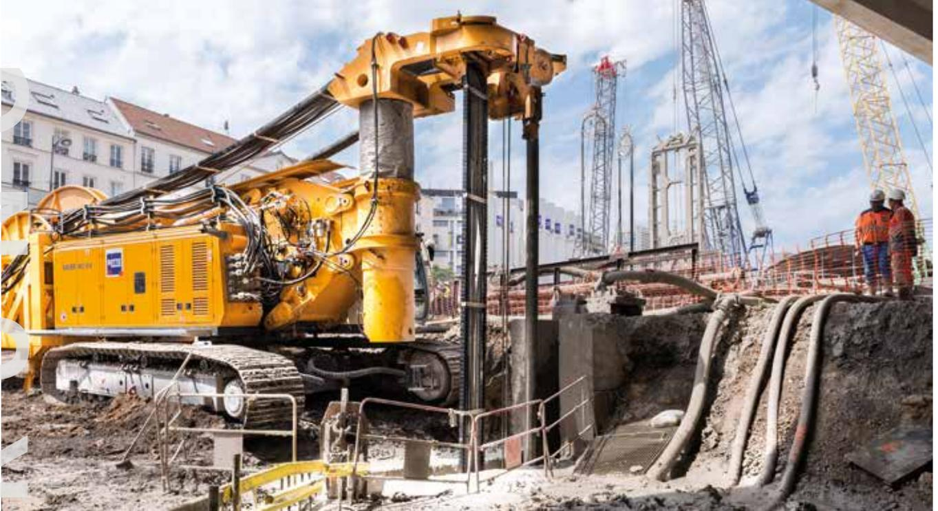
MC 64 mit Schlitzwandfräse der Low Headroom-Variante für den Bau einer Tiefgarage in Paris.
