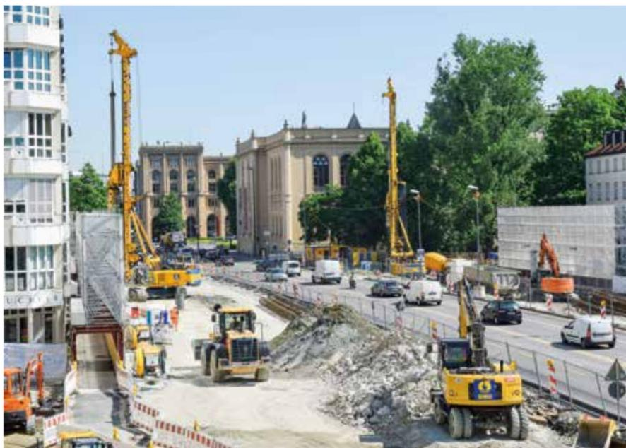
*Spezialtiefbau und Erdarbeiten für eine mehrgeschossige Tiefgarage unter dem östlichen Altstadtring in München.*
