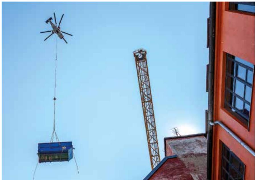
*Diese Wasserreinigungsanlage der Bauer Umwelt mit einem Gesamtgewicht von 4,5 t wurde mit einem Helikopter aus ihrer Baugrube in der Münchner Innenstadt gehoben.*
