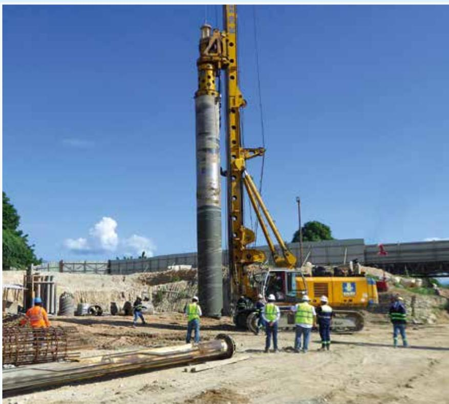
**Dominikanische Republik** Für den Bau des neuen Montegrando Damms am Yaque del Sur River werden rund 30.000 m<sup>2</sup> Dichtwand bis in 30 m Tiefe hergestellt. Für die Arbeiten kommt unter anderem ein MC 96 Seilbagger mit einer BC 40 Fräse zum Einsatz. **oben**
