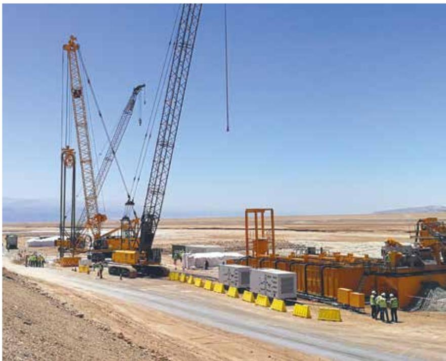
**Jordanien** Zur Abdichtung von Erdbecken, in denen durch Verdunstung von Salzwasser aus dem Toten Meer eine Sole zur Herstellung von Pottasche entsteht, werden aktuell etwa 112.000 m<sup>2</sup> Schlitzwand mit eingestellten Spundwänden hergestellt. Zusätzlich müssen 790.000 m<sup>3</sup> Erdreich zur Deichverbreiterung bewegt werden. **oben**
