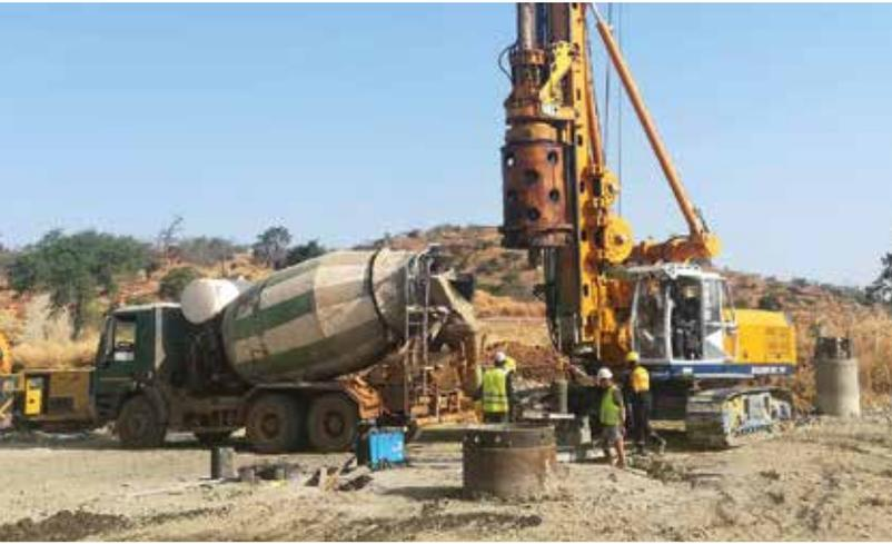
**Katar** Für die neue U-Bahn-Linie Red Line in Doha wurden 333 Manschettenrohre gebohrt und installiert, um insgesamt rund 4.000 m<sup>3</sup> Injektionsmaterial zur Stabilisierung des Bodens einzubringen. **unten**
