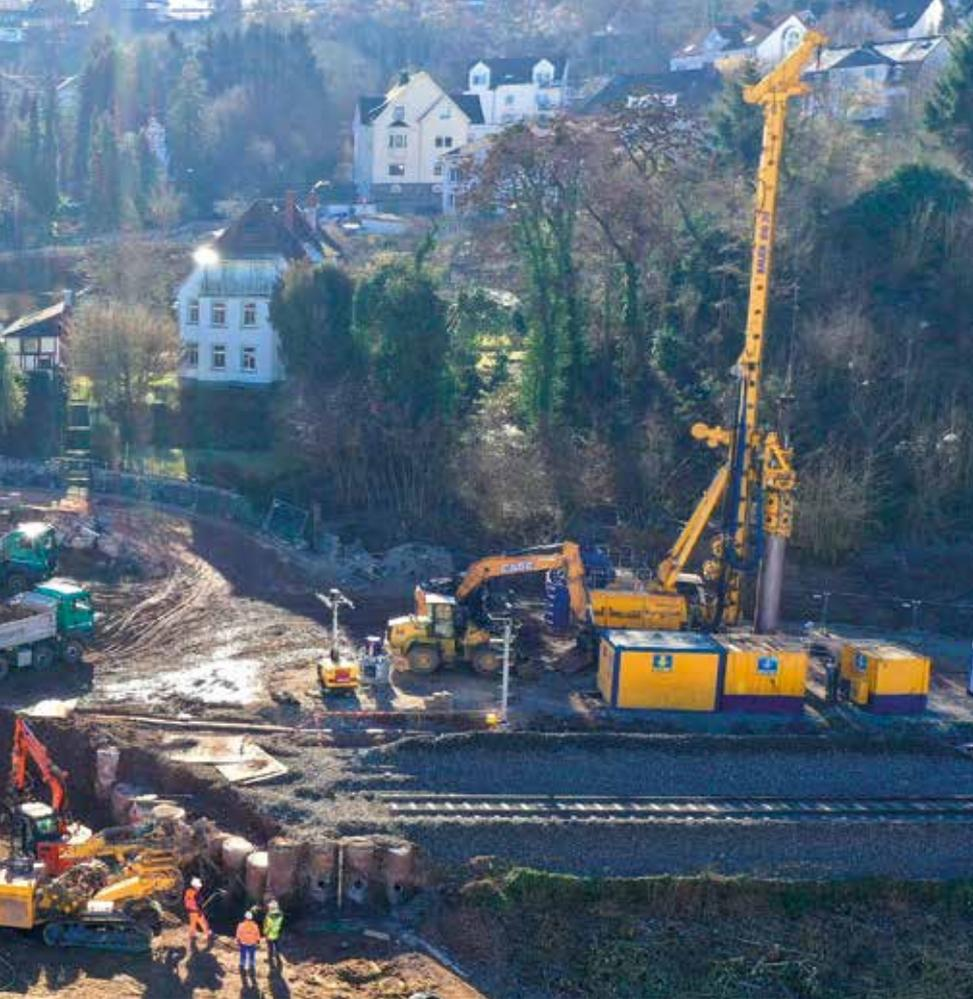
Während Sperrpausen der Deutschen Bahn wurden bei **Diez** in Rheinland-Pfalz die Gleise der angrenzenden Bahnstrecke ausgebaut, die benötigten Bohrebenen hergestellt und an insgesamt zehn Wochenenden Gründungspfähle, Pfahlwände und Rückverankerungen ausgeführt. **links**
