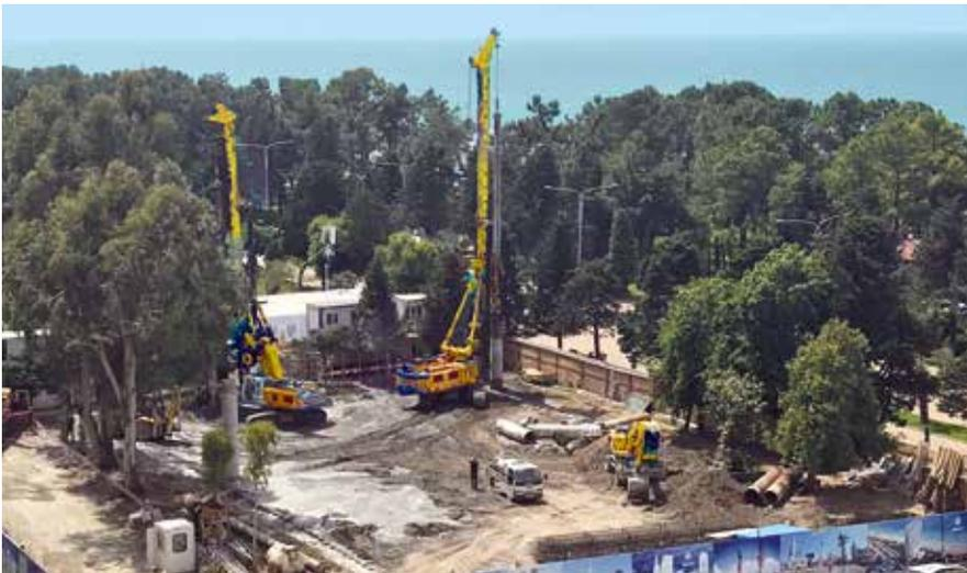
**Georgien** Für ein Erholungszentrum mit Hotel am exklusiven Batumi Boulevard am Schwarzen Meer wurde mit einer Länge von 62,3 m der tiefste und mit einem Durchmesser von 1.500 mm der größte Bohrpfehl hergestellt, der jemals in Georgien ausgeführt wurde. **oben**
