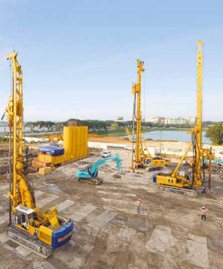
**Malaysia** Insgesamt drei Rekorde wurden für die Bohrpfahlarbeiten am Projekt Lot L&M im KLCC – dem Kuala Lumpur City Center – aufgestellt. Bauer gründete für die Wolkenkratzer die bisher tiefsten Pfähle in Malaysia, und das mit dem aktuell größten Bauer-Bohrgerät BG 72 und der mit 150 m weltweit längsten Kellystange. **unten**
