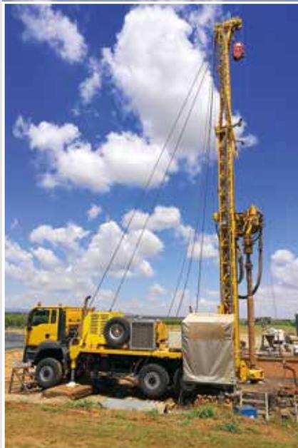
**Türkei** Unser Kunde Sezerler Zemin Ins. San. Tic. Ltd. Sti. brachte mit einer BG 28 H mit Kelly-Ausrüstung mehrere Bohrpfähle zur Absicherung einer Pipeline gegen Erdbeben ein. **unten**
