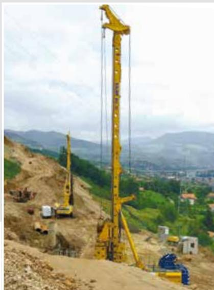
**Deutschland** Die Porr Equipment Services GmbH nutzte zur Herstellung einer überschnittenen Bohrfahlwand für ein Wasserkraftwerk am Inn eine BG 45 V mit Kelly-Ausrüstung. **oben**
