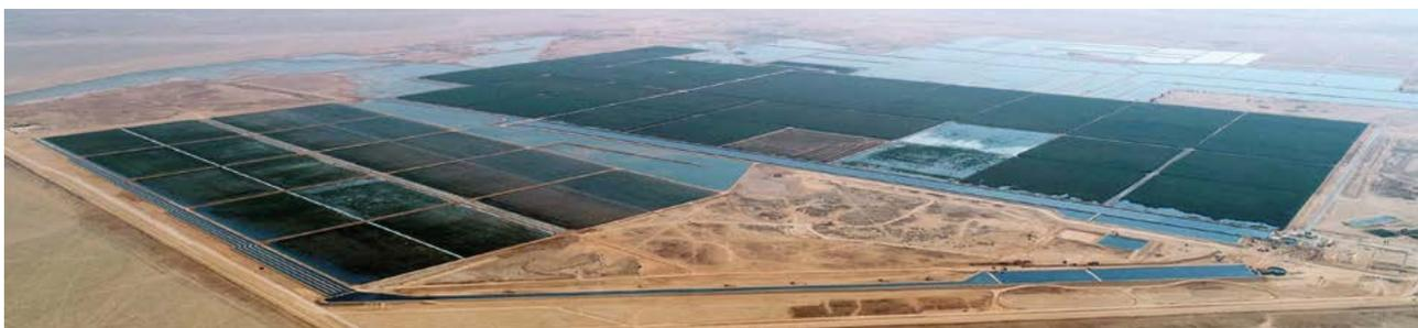
Die Pflanzenkläranlage im Oman reinigt nicht nur täglich 175.000 m<sup>3</sup> verunreinigtes Wasser, durch die Einsparung von CO<sub>2</sub>-Emissionen konnten 2019 auch Emissionszertifikate für 114.000 t CO<sub>2</sub> verkauft werden.
