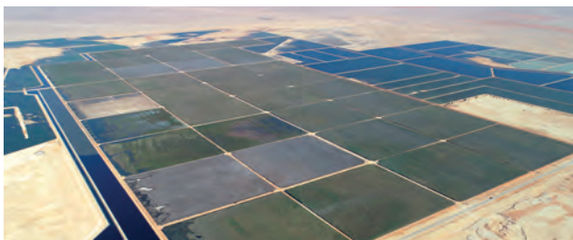
2011 stellte Bauer Nimr die erste Phase der Pflanzenkläranlage fertig. Heute ist die Anlage mit 13,5 km 2 in etwa so groß wie 1.600 Fußballfelder.
