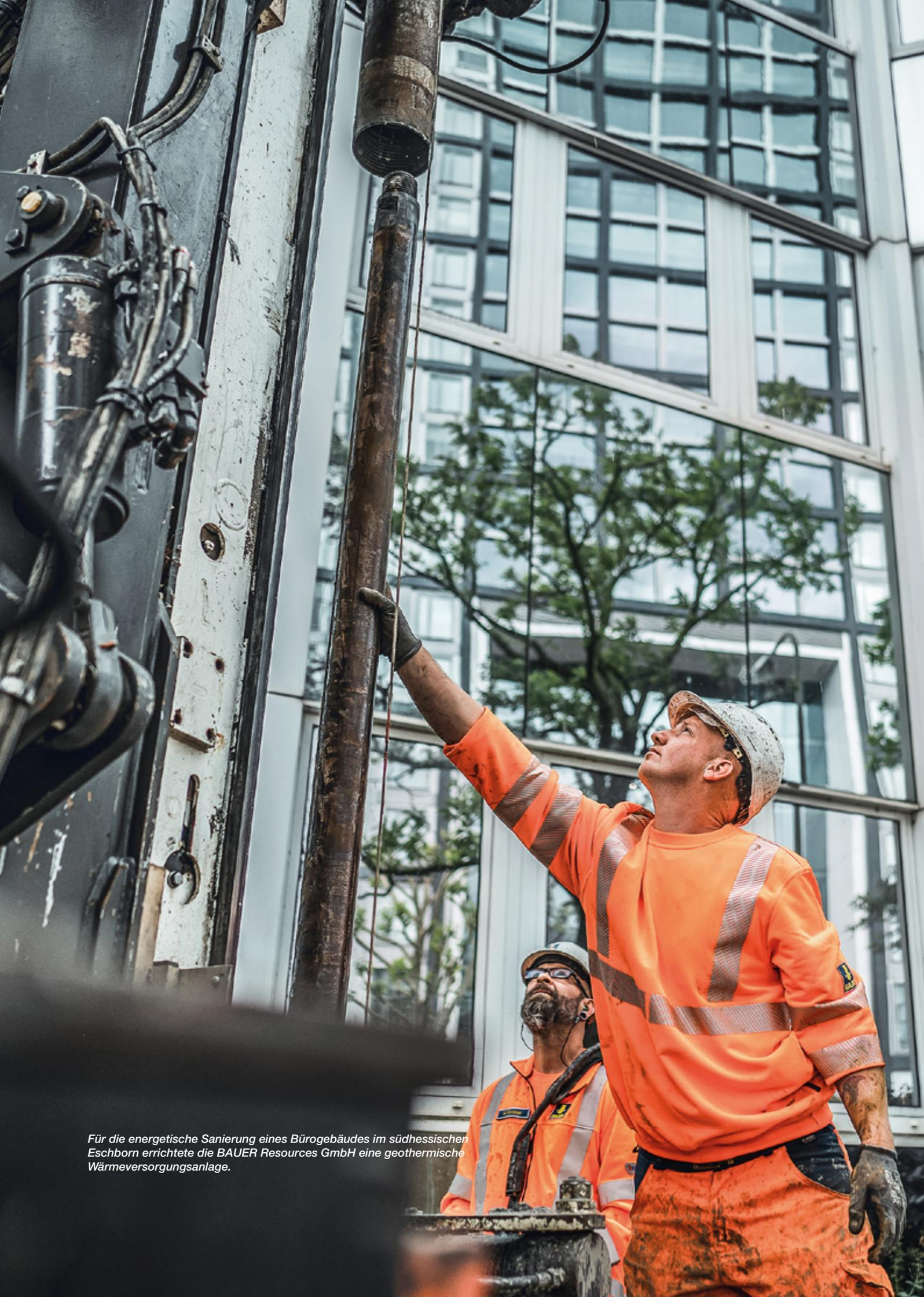
*Für die energetische Sanierung eines Bürogebäudes im südhessischen Eschborn errichtete die BAUER Resources GmbH eine geothermische Wärmeversorgungsanlage.*
