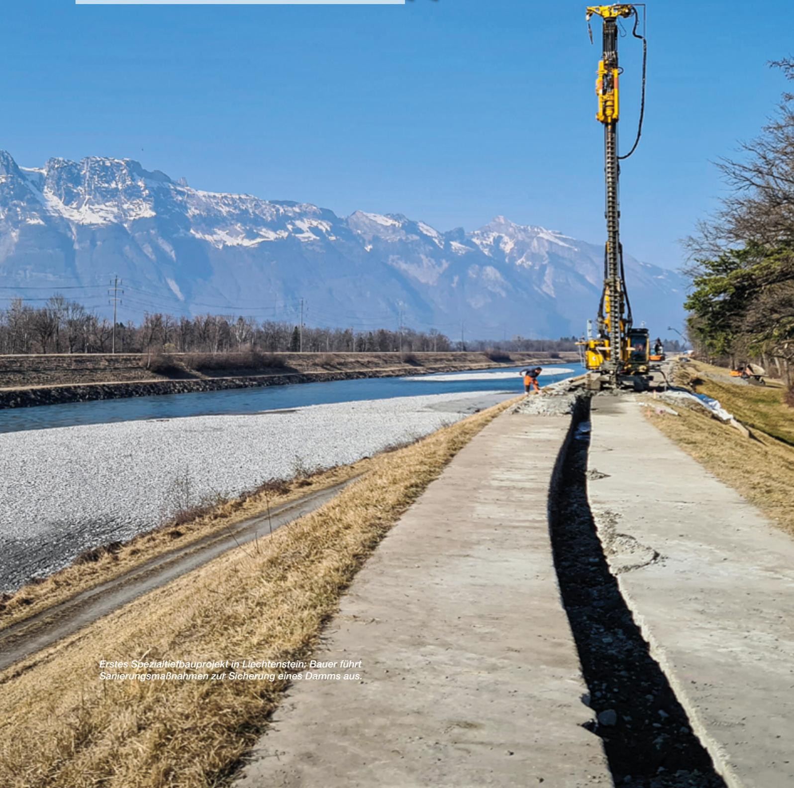
*Erstes Spezialtiefbauprojekt in Liechtenstein: Bauer führt Sanierungsmaßnahmen zur Sicherung eines Damms aus.*
