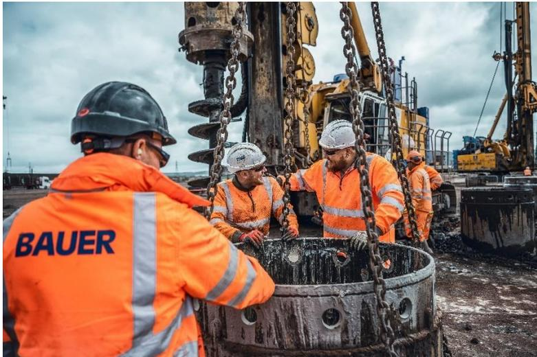
(1) Ein starkes Team bei der Arbeit: Rund 1.500 Bohrpfähle und 5.500 Schneckenortbetonpfähle bilden das Fundament für die geplante Monopile-Produktionsstätte.
