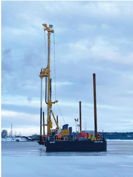
(1) Die Arbeiten mit einer BAUER BG 45 finden in Küstennähe von einer schwimmenden Arbeitsplattform aus statt.
