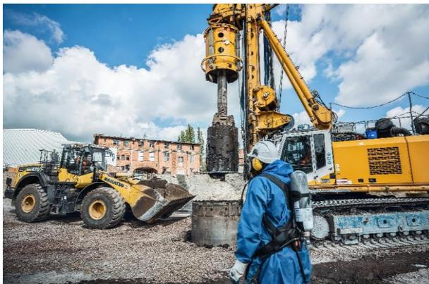
(3) Der Bodenaustausch erfolgt mittels Großlochbohrungen. Spezielle Schutzanzüge und eine Abluftreinigungsanlage dienen der Sicherheit von Arbeitern und Umfeld.
