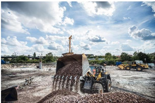
(2) Insgesamt werden rund 5.600 m<sup>3</sup> Erde ausgehoben und 3.350 m<sup>3</sup> an schadstoffbelastetem Material in bis zu 9 m Tiefe ausgetauscht.
