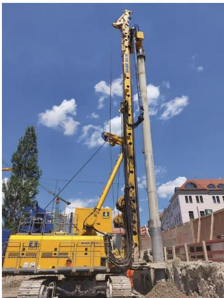
(2) Mit einer BG 30 werden Pfähle bis in 18 m Tiefe gebohrt.
