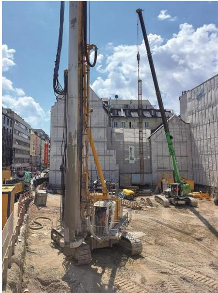
(1) Für den Baugrubenverbau stellt Bauer insgesamt 298 Bohrpfähle im Doppelkopfsystem her.
