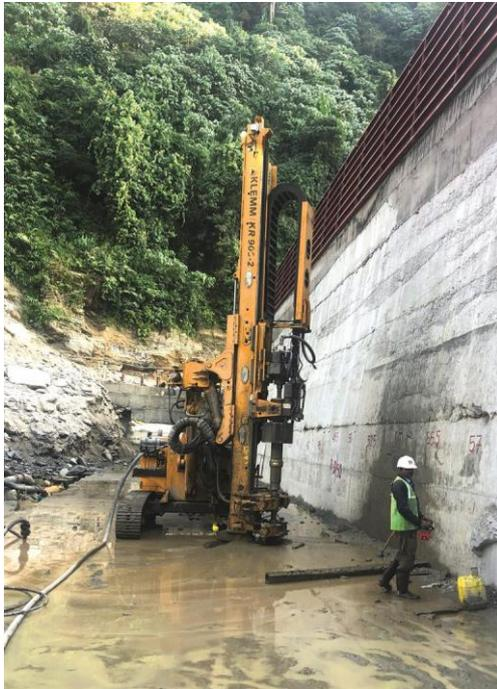
Für die Bohr- und Injektionsarbeiten wird eine KLEMM KR 909 eingesetzt.
