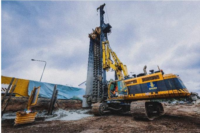
Für die Herstellung der Mixed-in-Place-Verbauwand mit einlagiger Rückverankerung wird eine RTG RG 25 S eingesetzt. © BAUER Group
