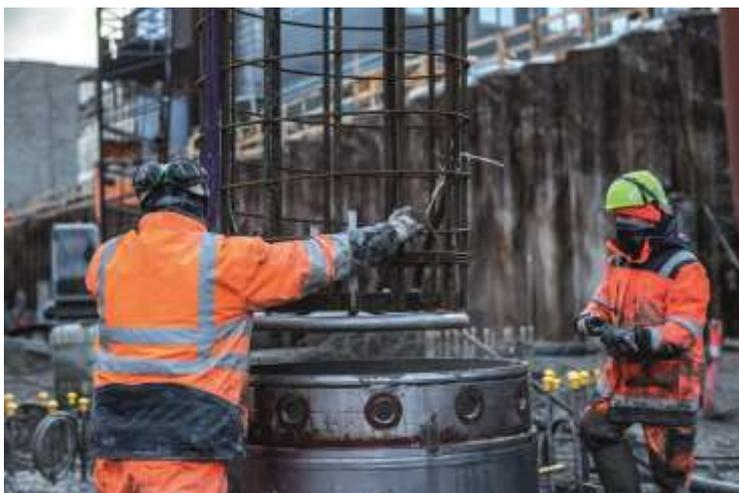
(2) Die Montage der BAUER Lift Cells erfolgte während der Tag-, das Verpressen im Gegenzug während der Nachtschicht, um ein absolut erschütterungsfreies Arbeiten zu ermöglichen.
