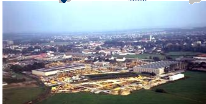
BAUER AG, Schrobenhausen, Germany
