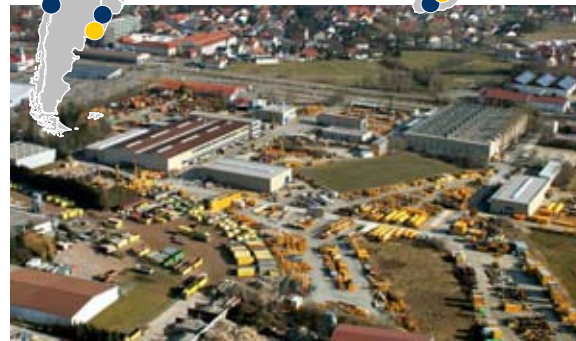
BAUER AG, Schrobenhausen, Germany
