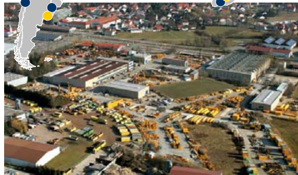
BAUER AG, Schrobenhausen, Germany
