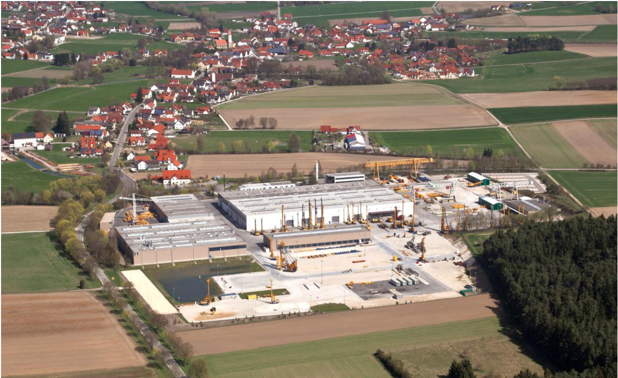
Abbildung 1: Luftbildaufnahme Werk Aresing
