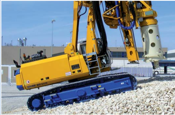
Beim Befahren einer Steigung muss der Fahrer den Schwerpunkt des Geräts und die Stellung des Masts unter Kontrolle haben.
