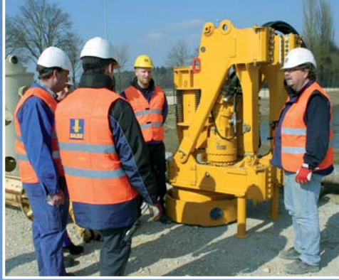
Einweisung in Maschinenkenntnisse – der Kraftdrehkopf ist das entscheidende Modul für die Bohrungen.
