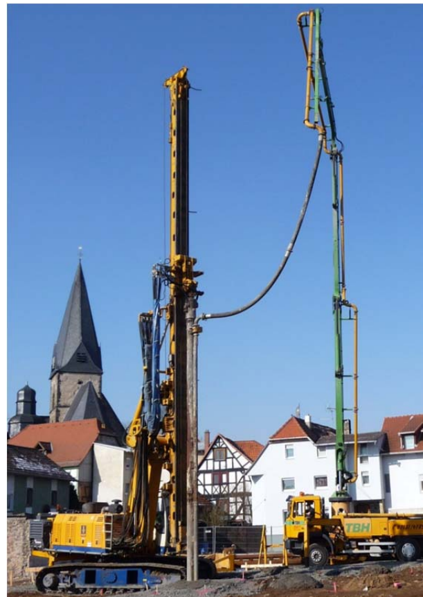
Abb. 15: BAUER BF 12 beim Herstellen von ROB-Säulen
