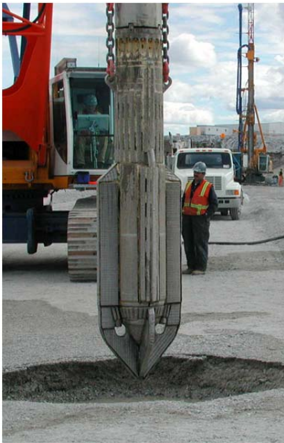
Abb. 2: RDV mit Kran und TR 75
