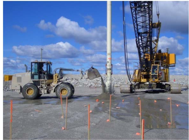
Abb. 6: Zuführung von Zugabematerial mittels Radlader
