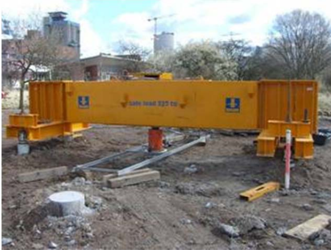
Abb. 23: Vorrichtung zum Prüfen einer ROB-Säule
