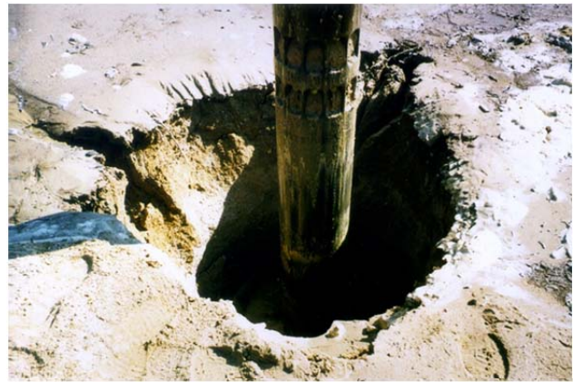
Abb. 8: Ausbildung eines Trichters beim Verdichten des Bodens mit einem Rüttler
