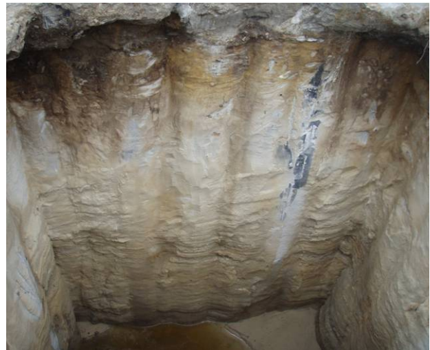
freigelegter Testschacht; Sydney (Australien)
