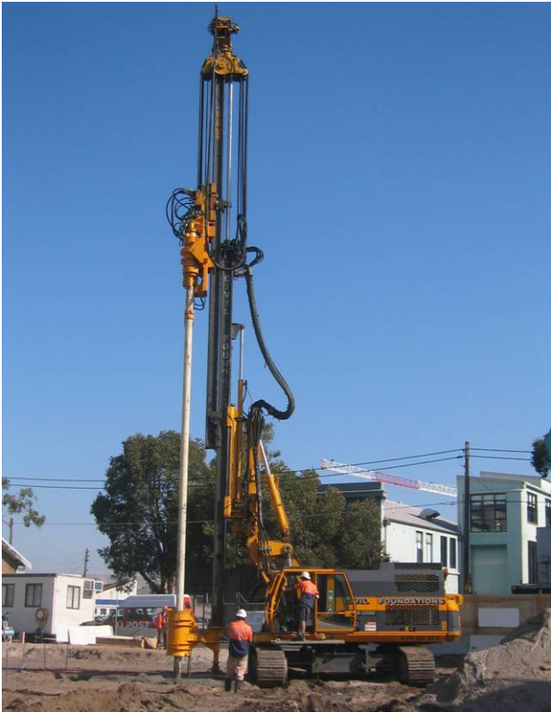
Verbauwand mit RG, Sydney (Australien)
