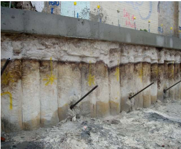
freigelegte Verbauwand; Sydney (Australien)
