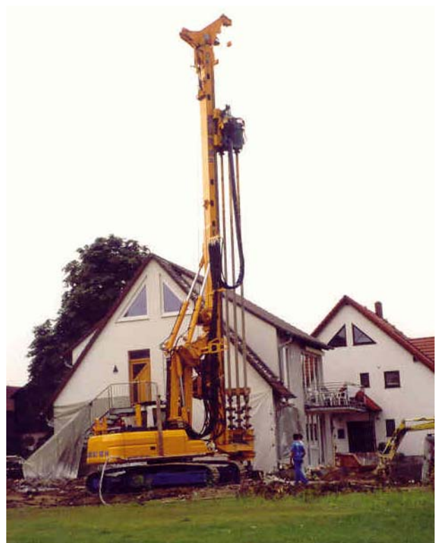
Dichtwand mit BG, Oberhausen
